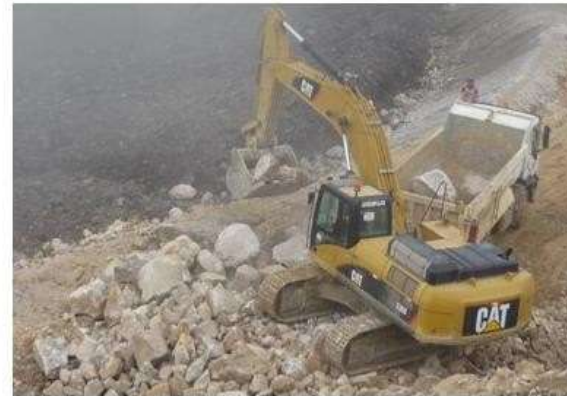
Zona V: Enrocado de para Espaldón
