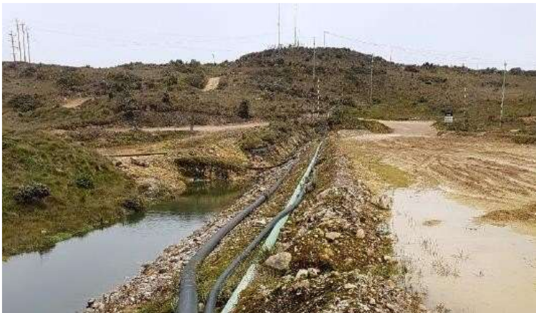
Figura 27: Vista aguas abajo de la presa lateral
