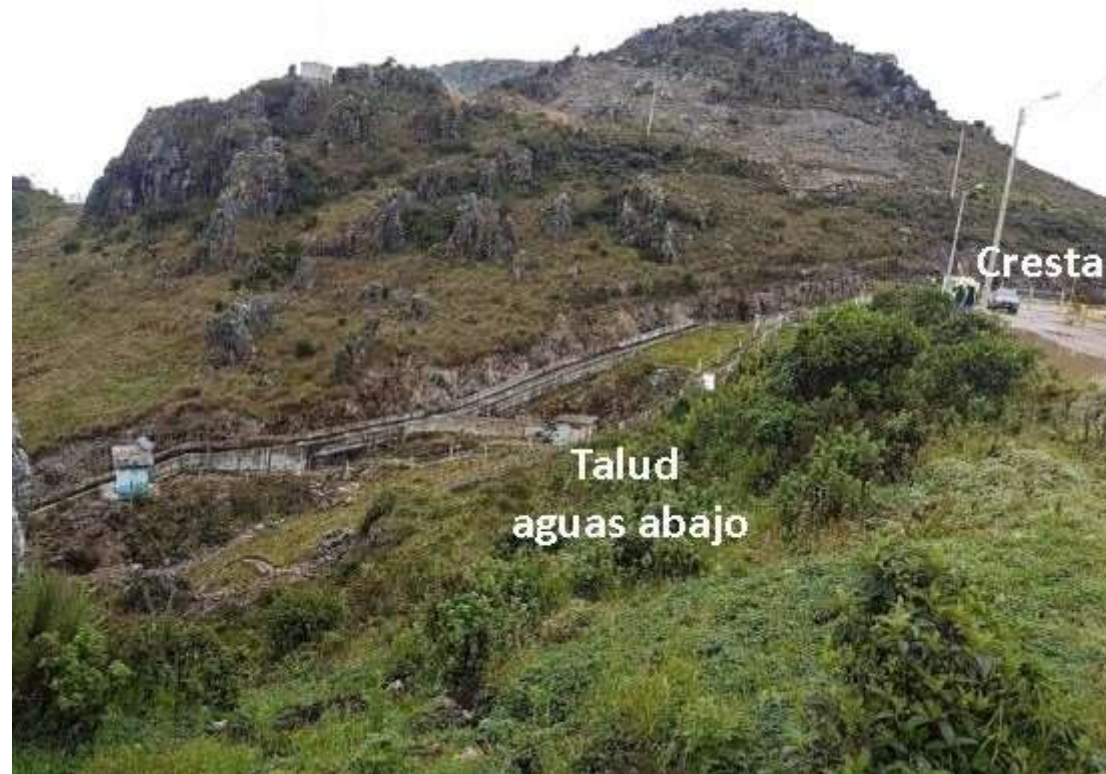
Ilustración 5: Vista de la cara aguas abajo de la presa principal
