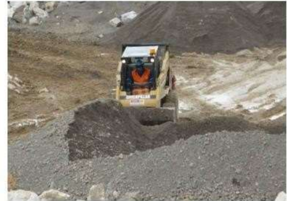
Zona III: Filtro Grueso
