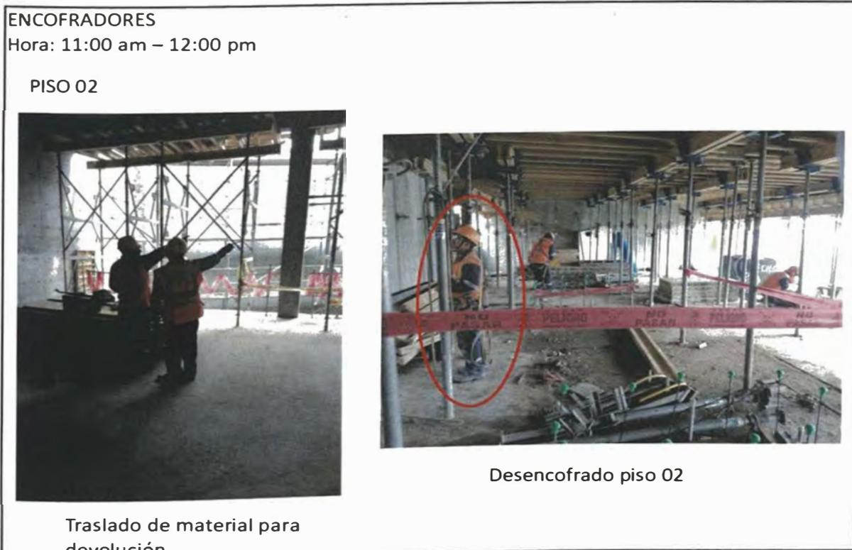
Figura 66. Material y piezas de encofrado utilizado en el Piso 02
