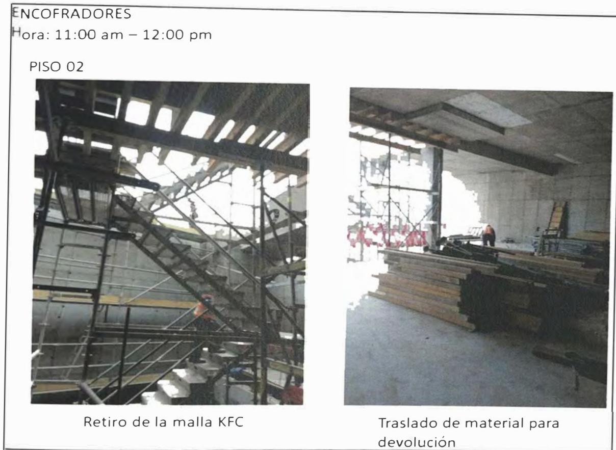
Figura 67. Material y piezas de encofrado utilizado en el Piso 02
