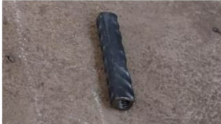
Figura 21. Conector mecánico de diámetro nominal de 19.1mm (3/4")
