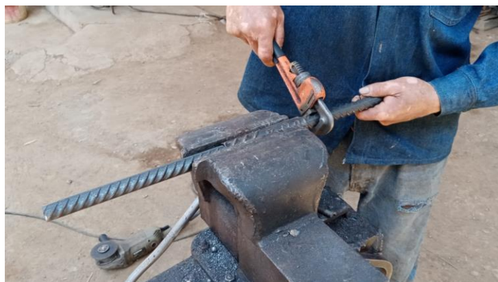
Figura 22. Pretensión de empalme mecánico
