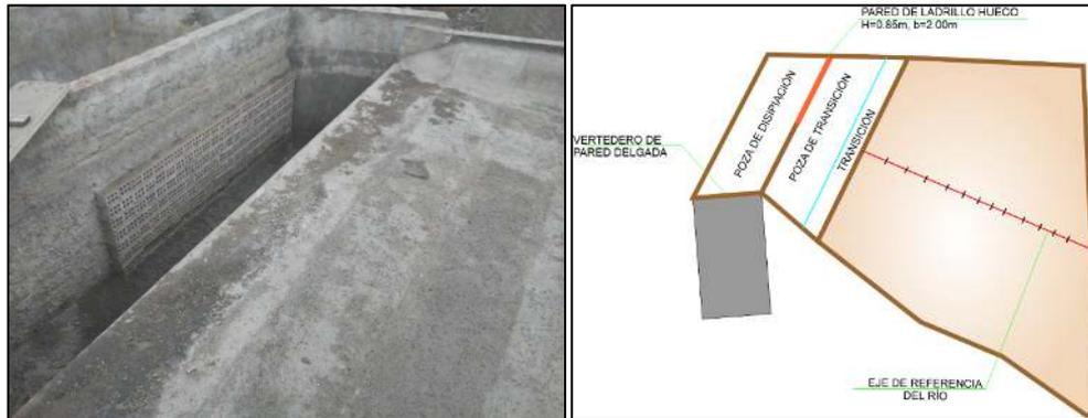
Figura 3.2 Muro de ladrillos para controlar el flujo entrante
