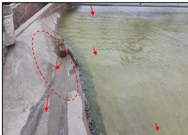
El agua en contacto con el muro de la margen derecha del barraje laminador estuvo en una situación de desborde inminente, situación similar ocurrió en la margen derecha del barraje partidor, esto se muestra en la Foto 3.7. En los muros de la margen izquierda de los barrajes laminador y partidor, el borde libre fue superior a 0,70 m.
