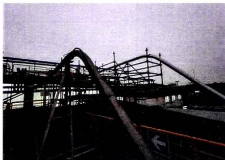
Figura 5.15 Tendido de tubería de acero inoxidable
