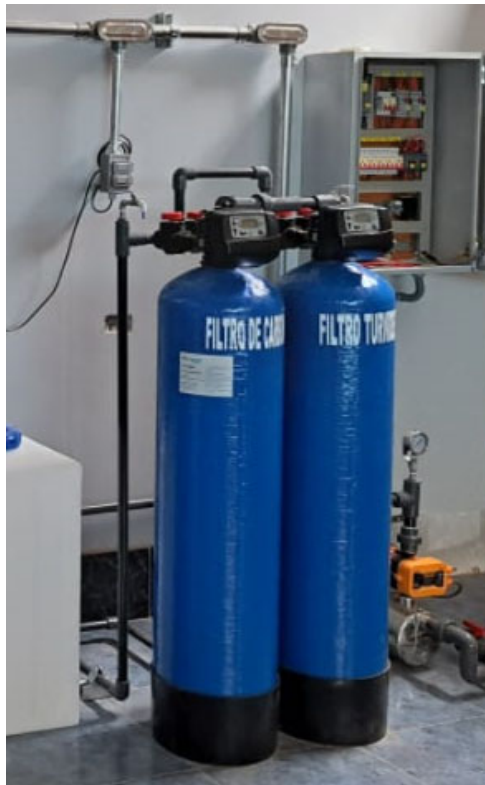
Filtros de carbón activado-dúplex en serie
