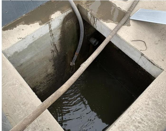
*Nota:* Cámara de bombeo compuesta de dos cámaras interconectadas. En la segunda cámara se tiene un sensor de pH, un transmisor de presión y dos bombas sumergibles de 1.1 kW.
