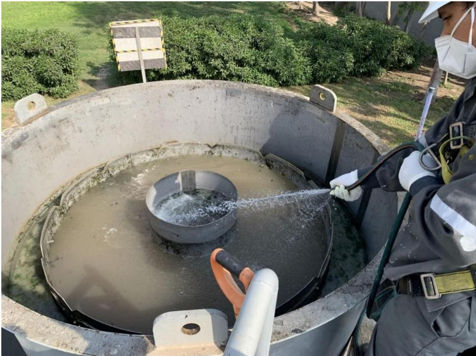
*Nota:* Limpieza manual de lodos flotantes en la zona superior de salida del clarificador como parte de las actividades de operación de la PTAR.
