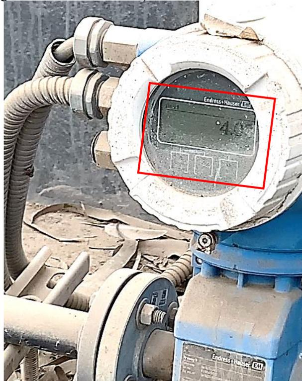
*Nota:* Flujómetro electromagnético tomando una lectura instantánea de 4.03 m<sup>3</sup>/h que se puede observar en su pantalla display del equipo.
