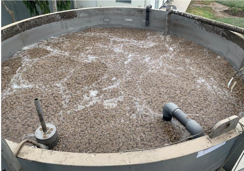
*Nota:* Reactor MBBR circular de 3.41 metros de diámetro evaluado en la investigación operando a condiciones normales.
