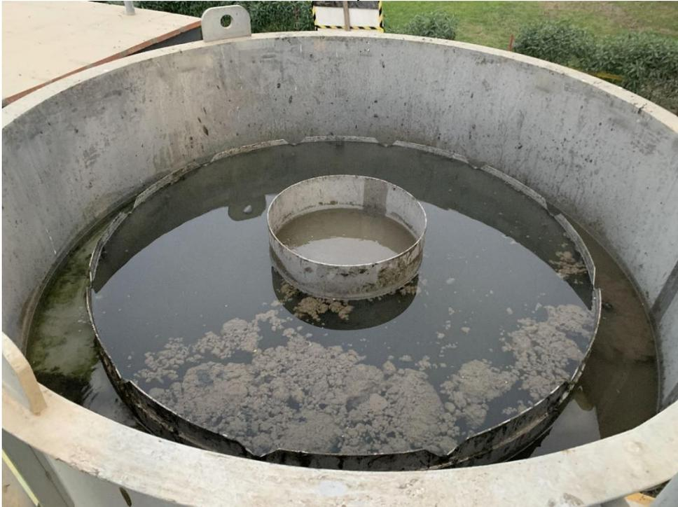
*Nota:* Presencia de sólidos flotantes en las fechas del 46 al 52 de la investigación debido a la excesiva producción de lodo por la operación a alta carga del reactor MBBR en el día 45. Este lodo fue detectado y removido posteriormente en el día 52 como parte de la operación de la PTAR.
