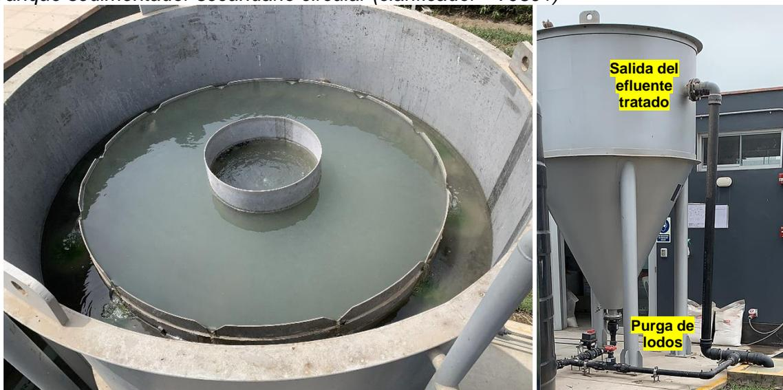
*Nota:* Clarificador circular de tecnología patentada. La disposición final del efluente tratado es el alcantarillado sanitario público (red de Sedapal) mientras que los lodos purgados son enviados a una unidad de deshidratación de lodos.
