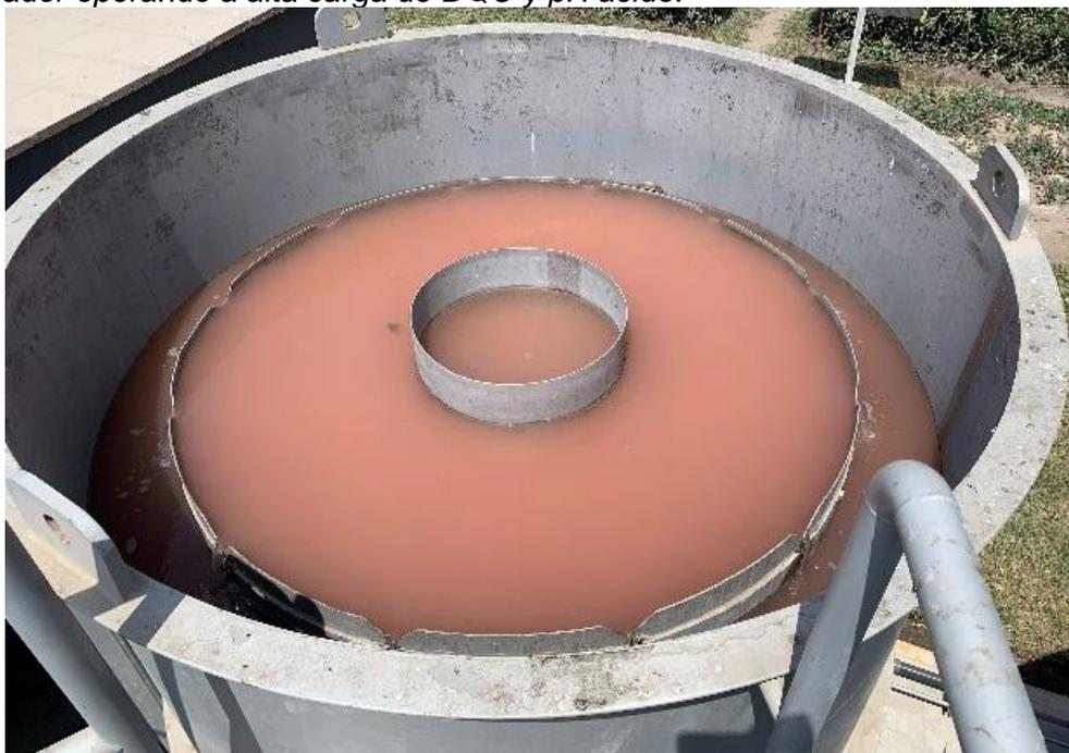
*Nota:* Clarificador operando a altas carga de sólidos por el evento extemporáneo sucedido el día 45 de la investigación por la descarga de un colorante de alta carga de DQO y pH ácido a la PTAR.
