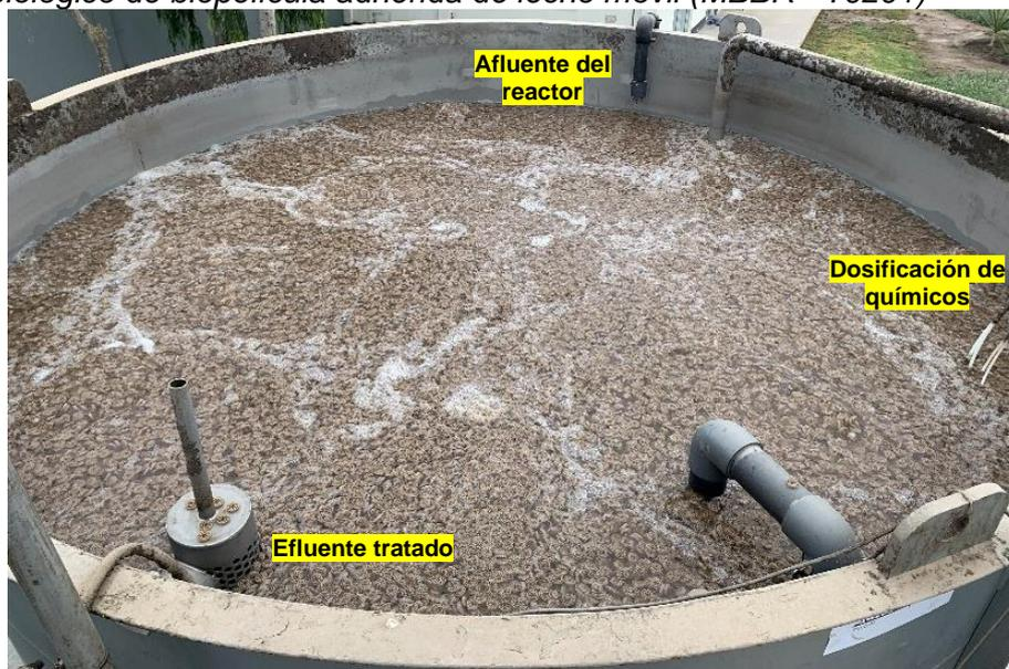
*Nota:* La imagen muestra el reactor MBBR circular evaluado en la presente investigación, con un sensor de pH, sensor de oxígeno disuelto y dosificación de soda cáustica, ácido clorhídrico, urea y antiespumante.
