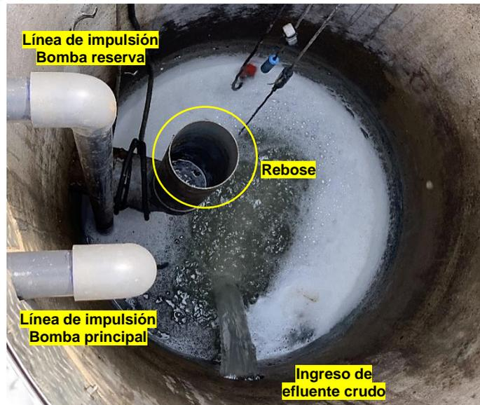
*Nota:* Tanque de almacenamiento circular de desagües de la PTAR, de 1.20 metros de diámetro con dos bombas sumergibles (bombas principal y bomba reserva) y tubería de reboso.
