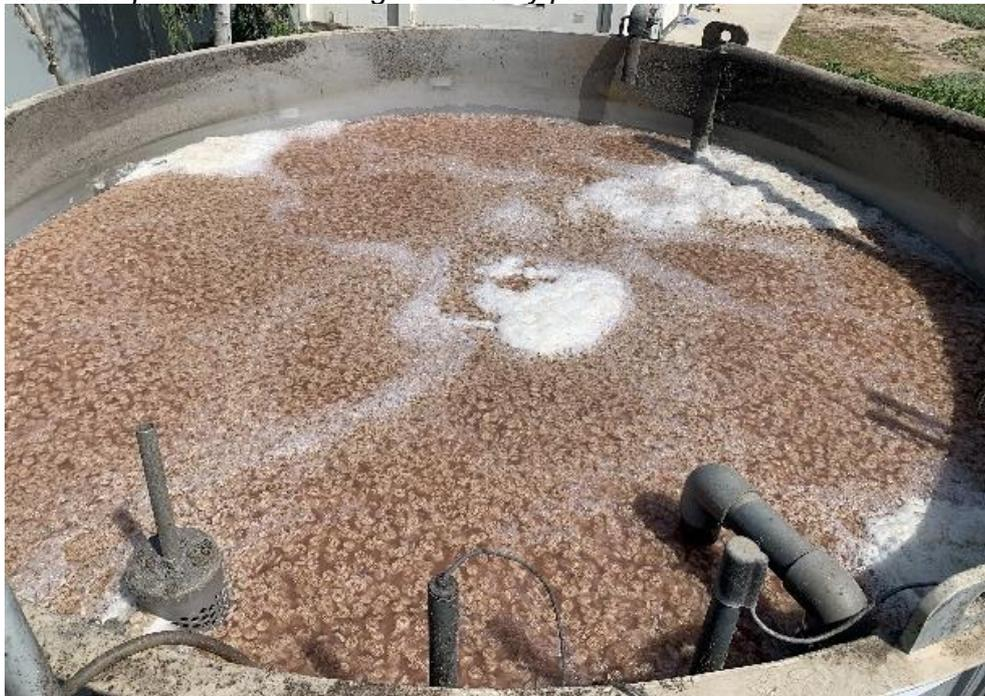
*Nota:* Reactor MBBR operando a alta carga de DQO por el evento extemporáneo sucedido el día 45 de la investigación por la descarga de un colorante a la PTAR.
