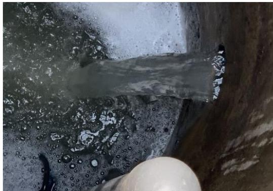
*Nota:* Tubería de llegada de 8 pulgadas con el caudal total que descarga en el tanque de almacenamiento.
