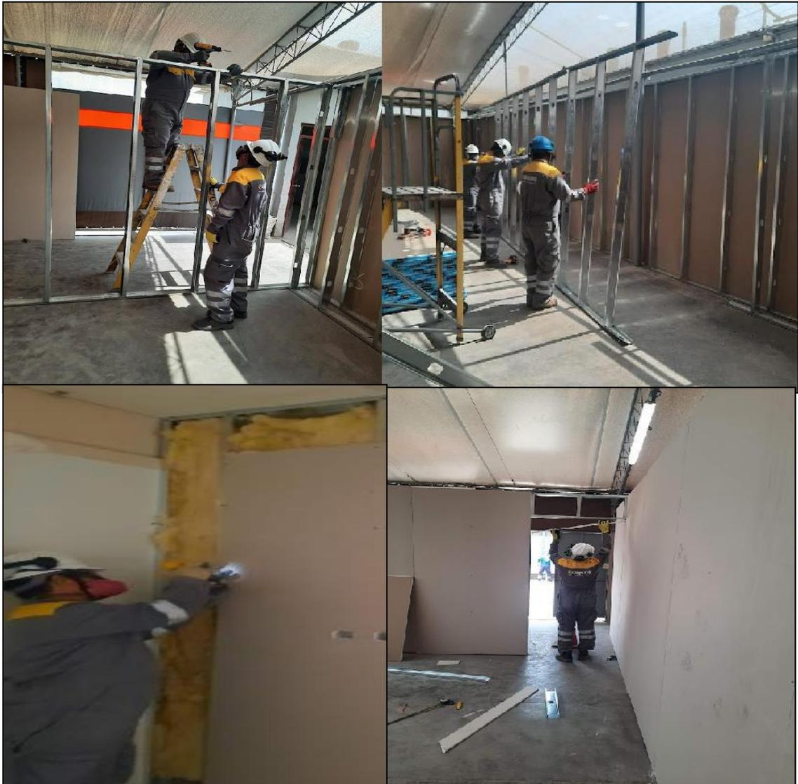
**Figura 2.9.** Instalador encargado de tabiquería y fijación de perfiles de aluminio
