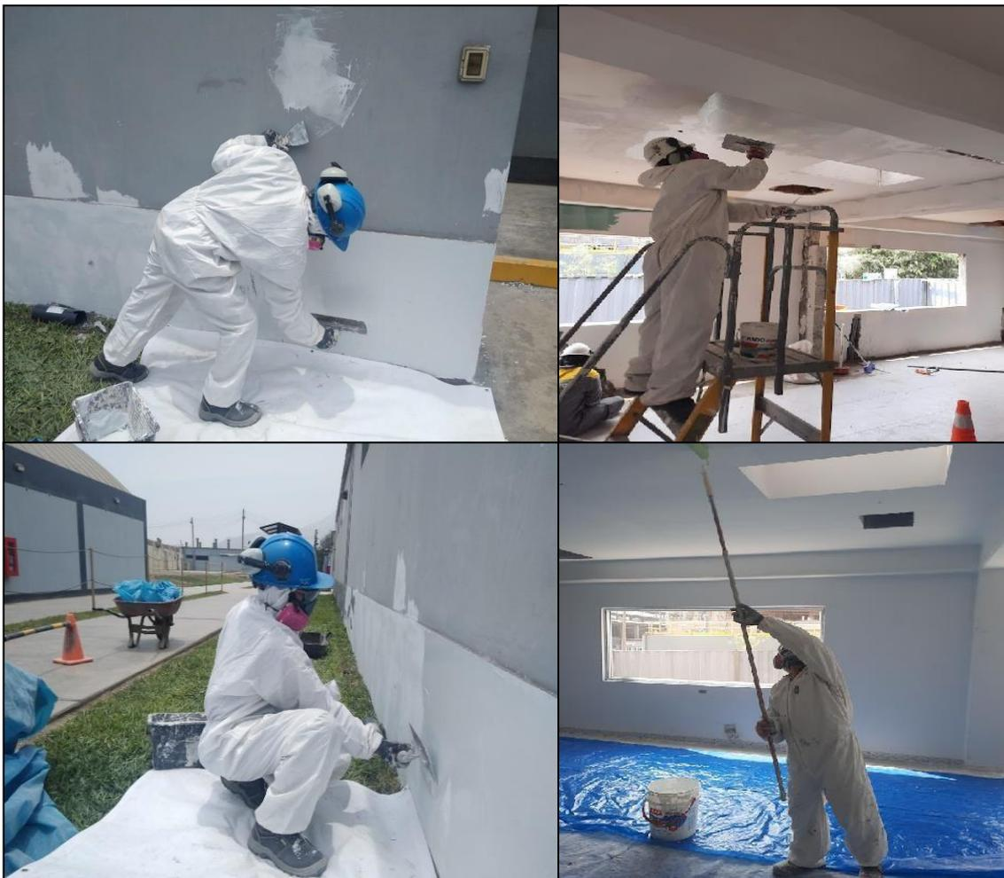
**Figura 2.10.** Pintor encargado de Pintado y Revestimiento – Empastado y lijado de Pared, Pintado de Pared
