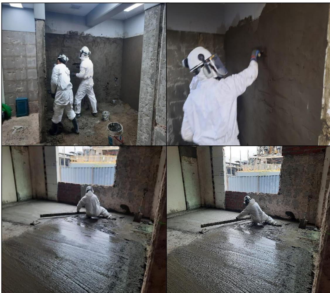
**Figura 2.6.** Operarios de construcción encargados de los revoques, enlucidos y tarrajeos.
