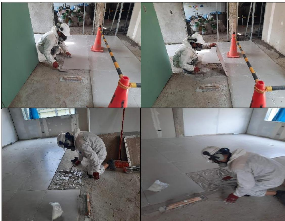
**Figura 2.7.** Operación de construcción encargados de enchapado, preparación y colocación de porcelanato.
