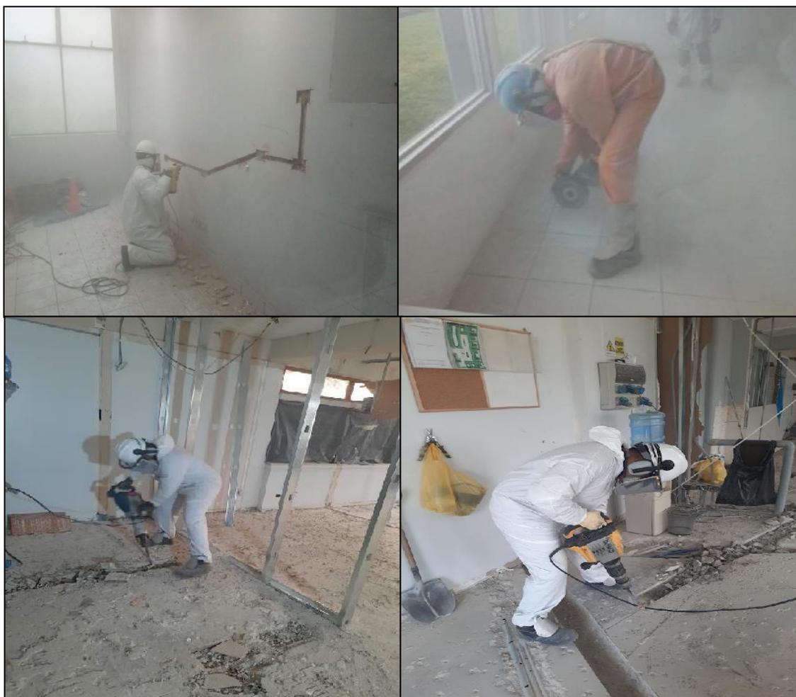
**Figura 2.5.** Operarios de construcción encargados en la demolición de paredes o estructuras
