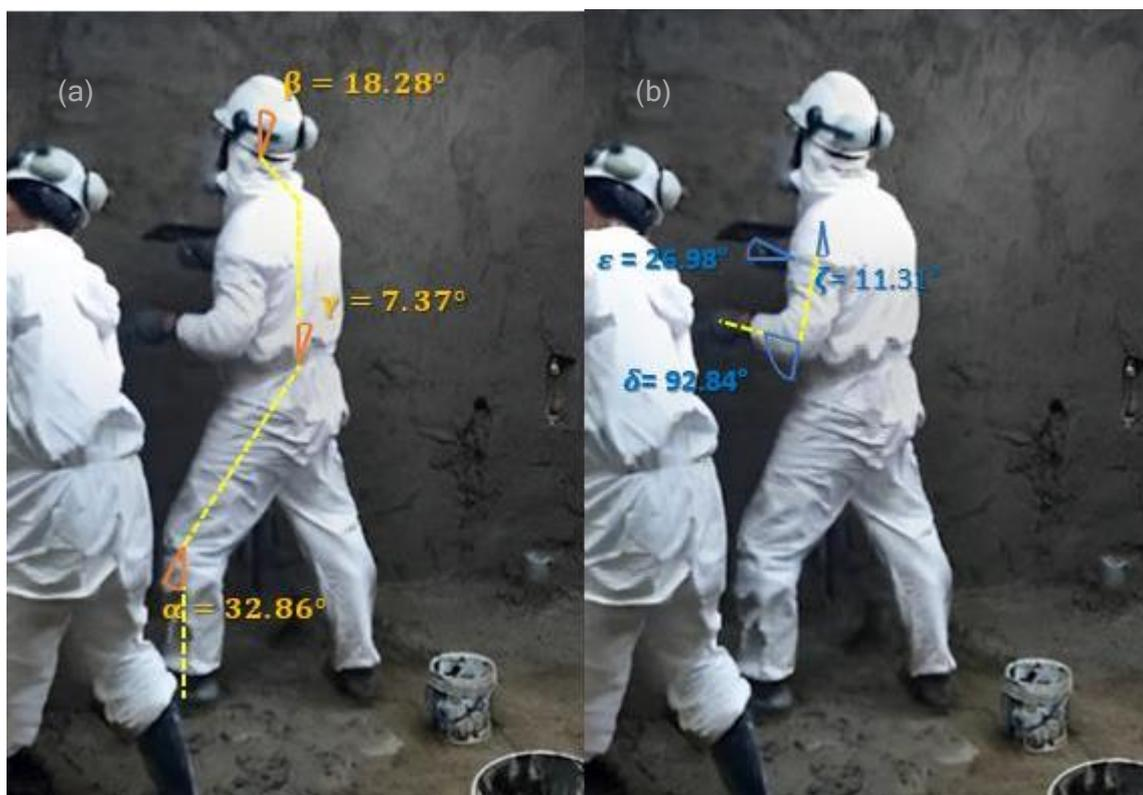
**Figura 3.22.** Actividad N°1 en el puesto de trabajo en Revoques, enlucidos y tarrajeo: (a) Mediciones angulares de las posturas del grupo A, (b) Mediciones angulares de las posturas del grupo B.
