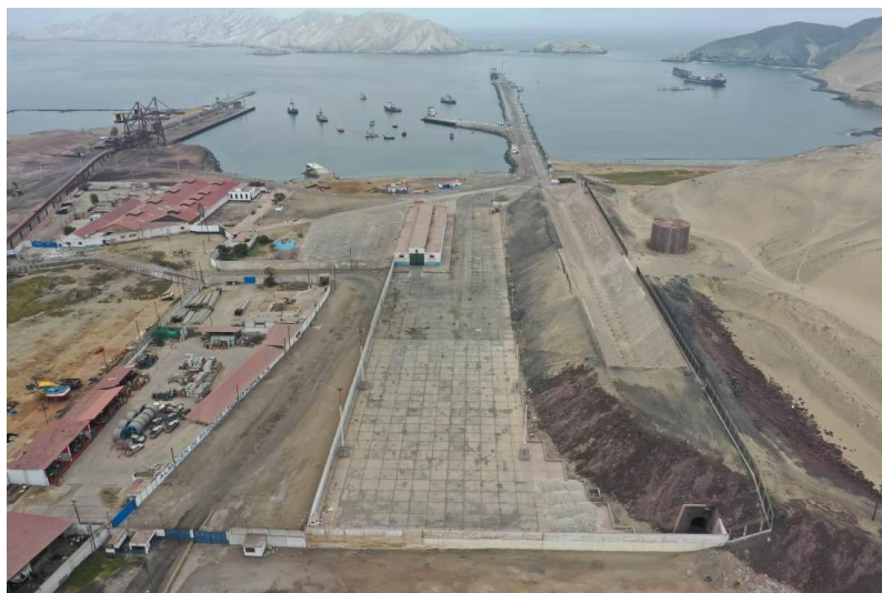
Figura N°3.12 Zona N°1 destinada a contenedores Fuente: Visita de campo
