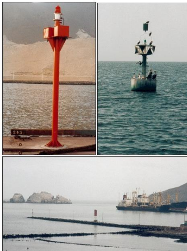
Figura N°3.7 Vista de la ubicación de las ayudas a la navegación Fuente: Plan Maestro del T.P. Chimbote, 2021
