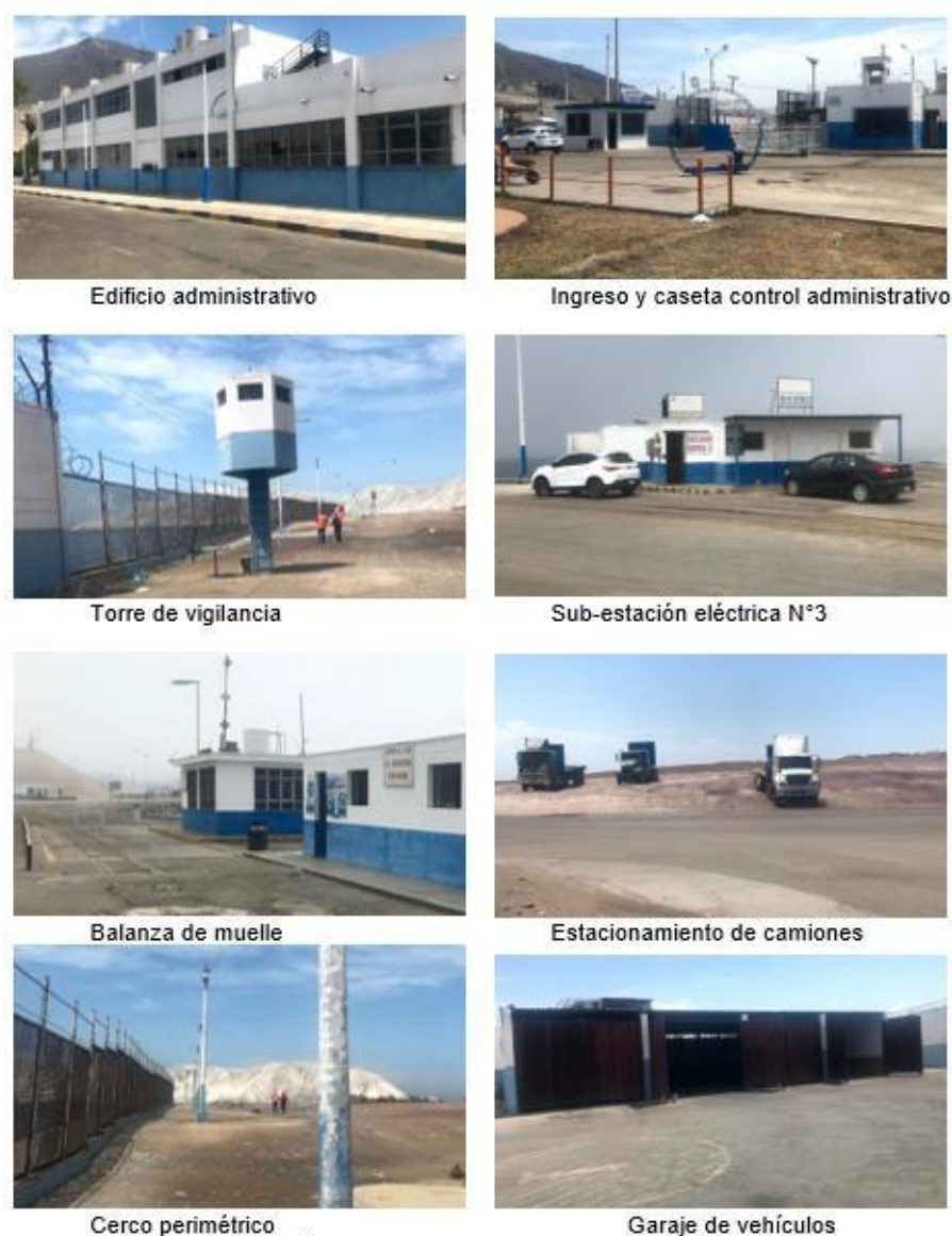
Figura N°3.15 Áreas administrativas y operativas Fuente: Visita de campo
