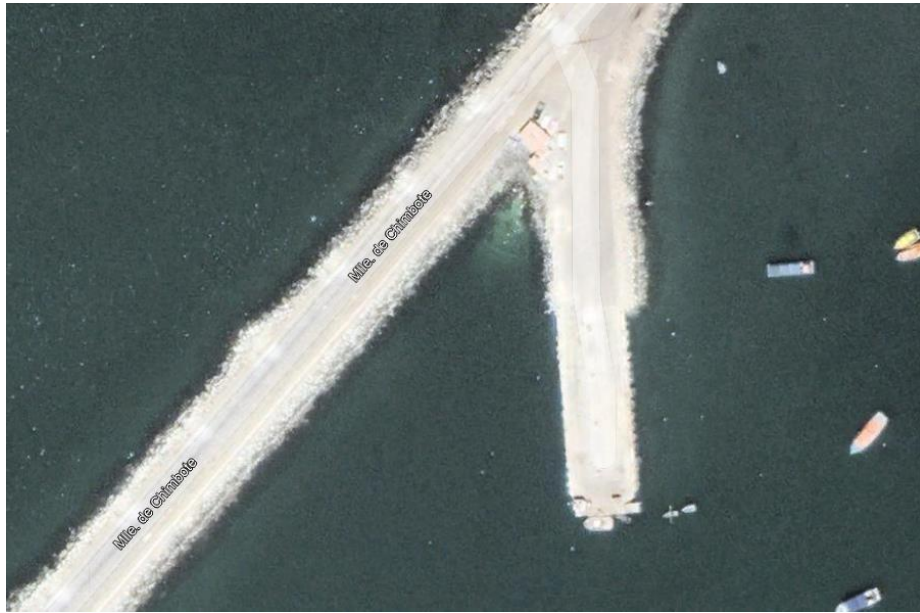
Figura N°3.9 Muelle N°2 Fuente: Google Earth
