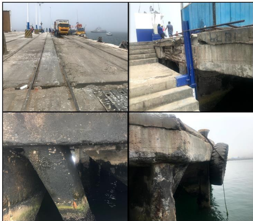
Figura N°3.10 Estado actual del muelle N°1 y N°2 Fuente: Visita de campo
