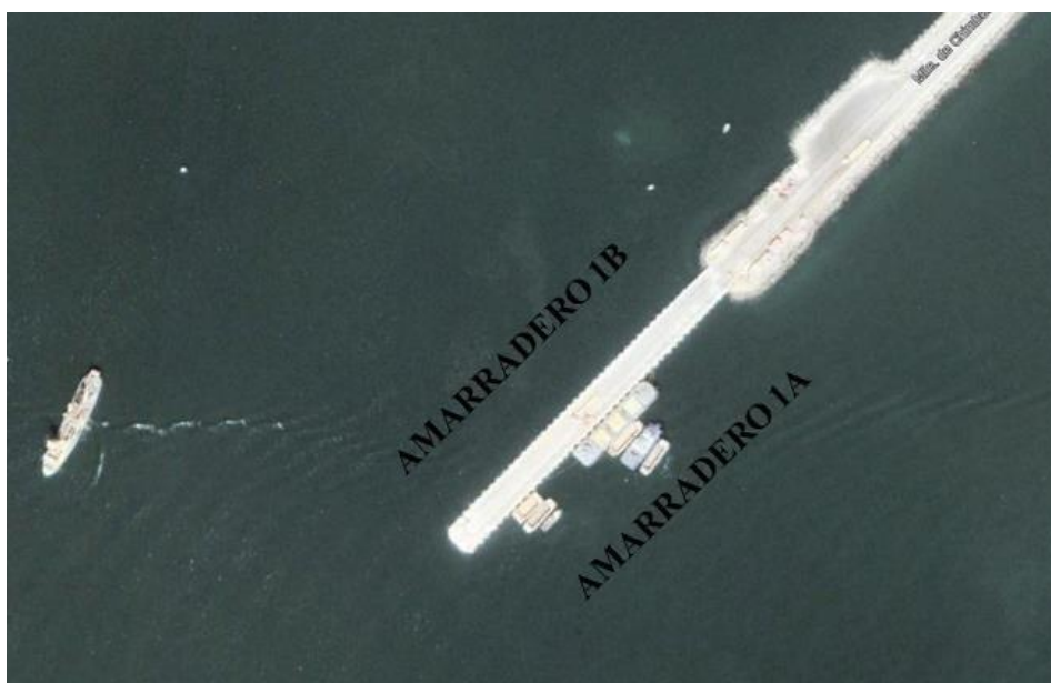
Figura N°3.8 Muelle N°1: Amarradero 1-A y 1-B Fuente: Google Earth
