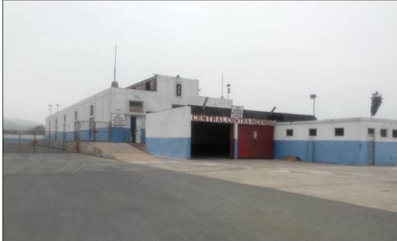
Figura N°3.11 Almacén N°1 Fuente: Visita de campo
