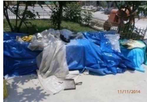
FOTO 3.4. Cemento cubierto con 2 mantas plástica y en 2 bolsas plásticas selladas
