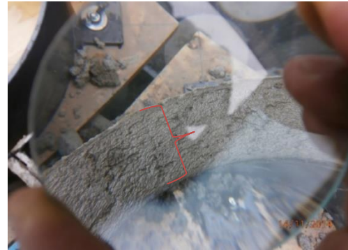
FOTO 6.2 Fisura en formación vista lente
