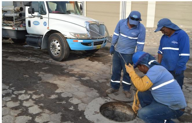
Figura 2.25 Limpieza manual de las alcantarillas
