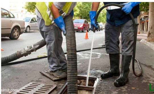
Figura 2.24 Limpieza de los tramos iniciales de las tuberías
