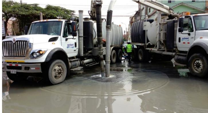
Figura 3.28 Máquinas Hidrojet durante un aniego
