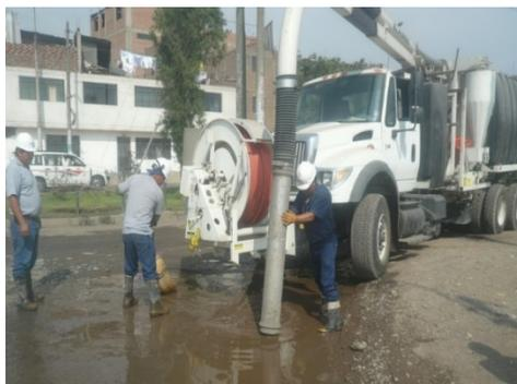
Figura 3.33 Máquina Hidro-Jet bombeando aguas residuales en el Rímac
