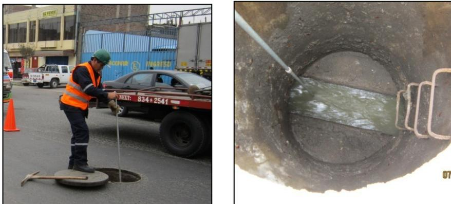
Figura 3.25 Operario realizando inspección visual
