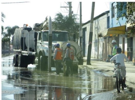
Figura 3.31 Máquina Hidro-Jet bombeando aguas residuales en Chorrillos
