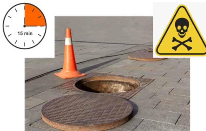
Figura 2.26 Ventilación de los gases venenoso
