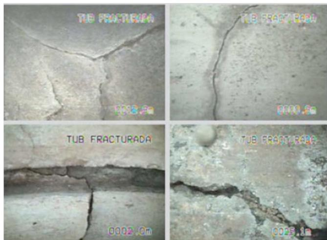
Figura 2.11 Captura del sistema CCTV de una fractura en tubería
