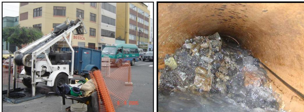
Figura 3.27 Máquina de balde en operación
