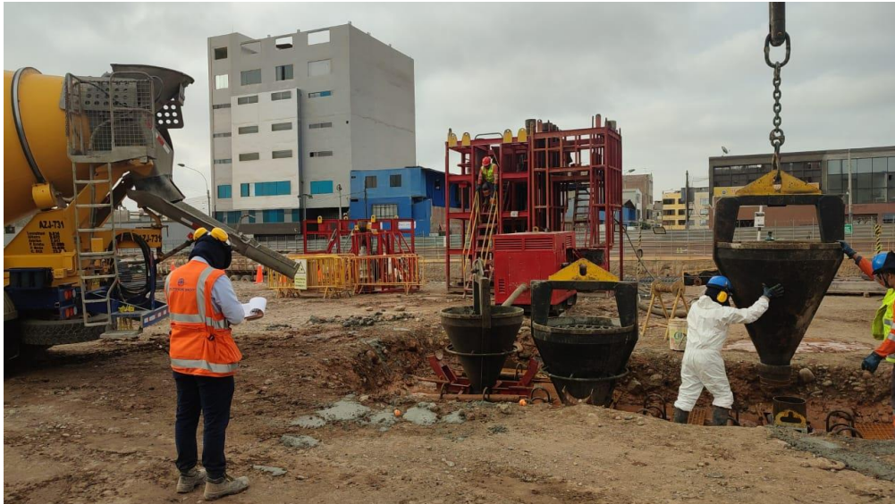
Figura N°4.43 Completando la curva “real” durante el proceso de colado.
