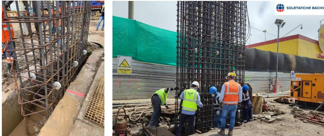
Figura N° 4.34 Referencias realizadas por topografía para dejar el acero centrado.
