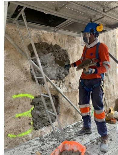
Figura N°4.52 Aplicación del puente de adherencia Sikadur 32 (a la izquierda), colocación del Sika Rep (a la derecha)
