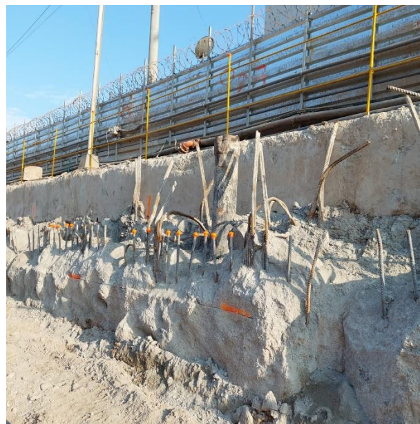
Figura N°4.49 Tubería tremie empotrado en muro diafragma.
