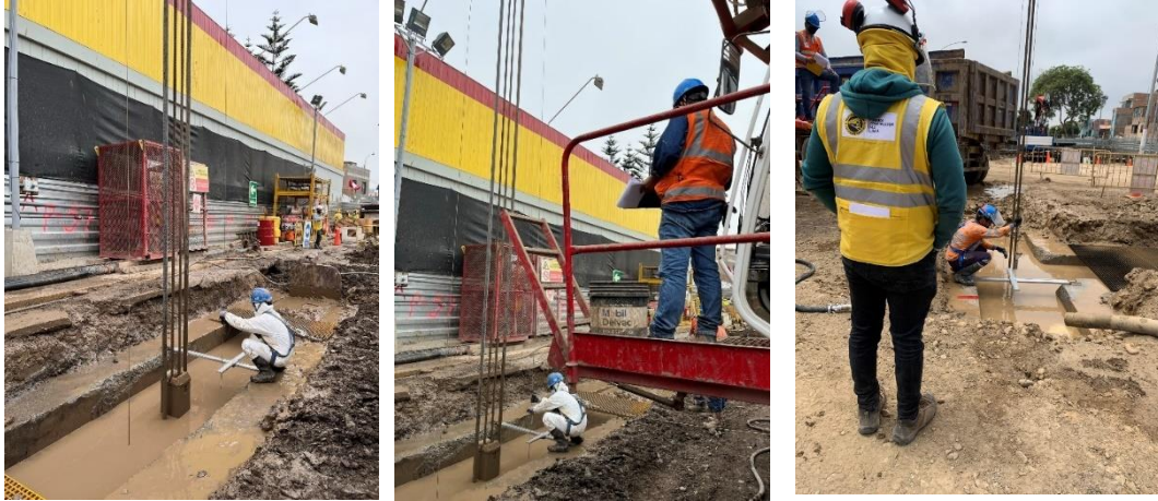
Figura N°4.12 Toma de verticalidad del panel.
