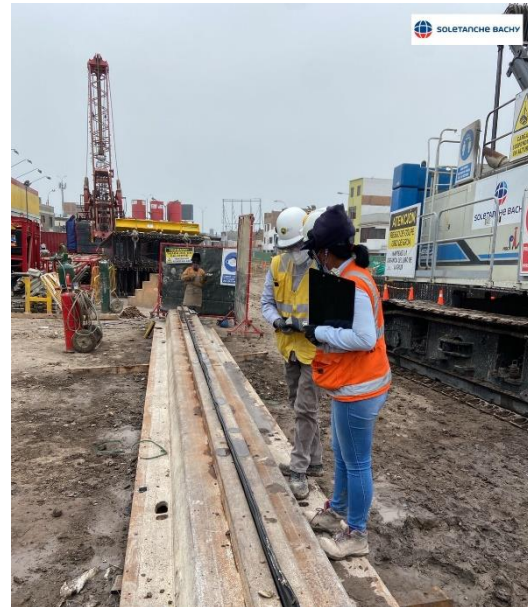
Figura N°4.25 Verificación de las condiciones del wáter-stop a colocar.
