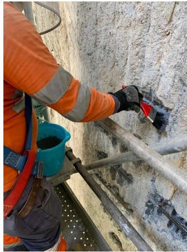
Figura N°4.52 Aplicación del puente de adherencia Sikadur 32 (a la izquierda), colocación del Sika Rep (a la derecha)
