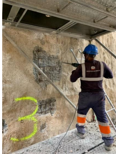
Figura N°4.50 Picado de tramo de muro diafragma contaminado.
