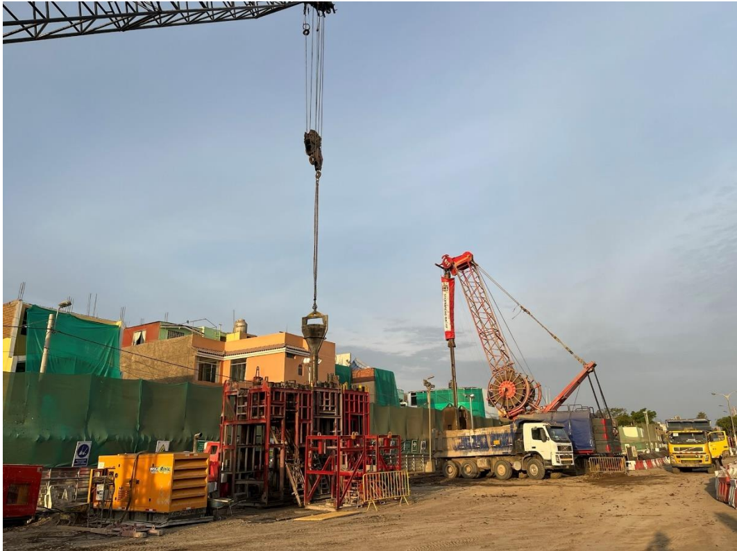
Figura N°4.36 Colocación de tubería tremie en panel.
