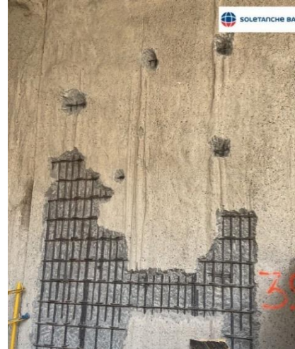
Figura N°4.50 Picado de tramo de muro diafragma contaminado.
