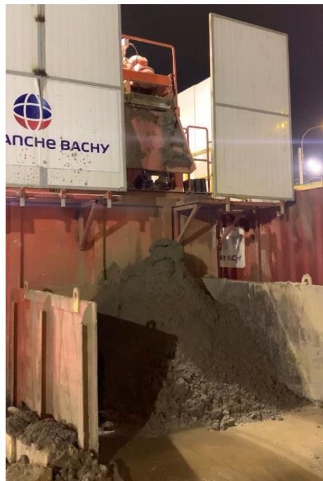
Figura N°4.16 Limpieza del lodo bentonítico de arena y limos.
