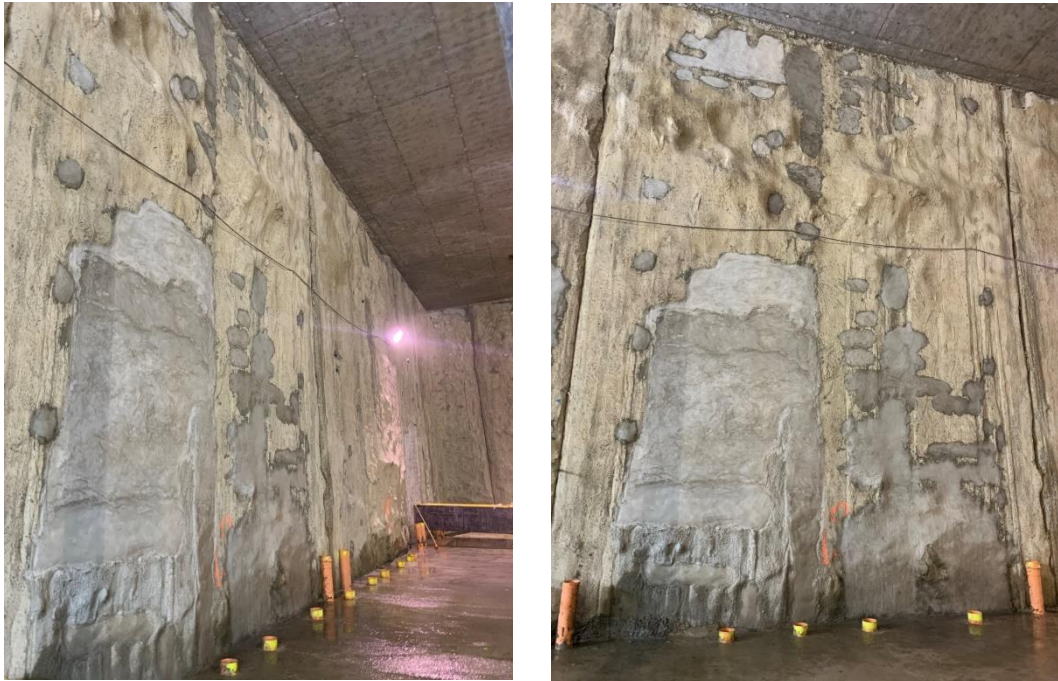
Figura N°4.54 Muros diafragma reparados.
