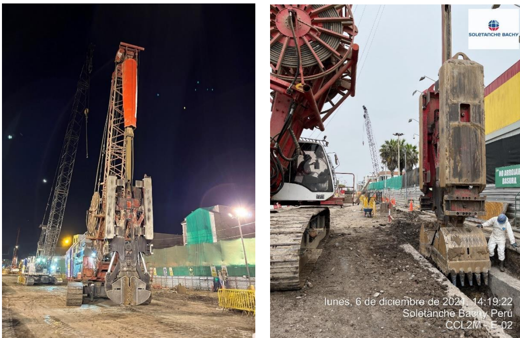
Figura N°4.5 Grúa Liebherr 855 con cuchara bivalva hidráulica.
