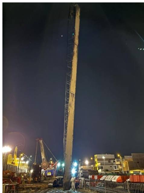
Figura N°4.23 Colocación de junta plana trapezoidal de 30.0m en panel.
