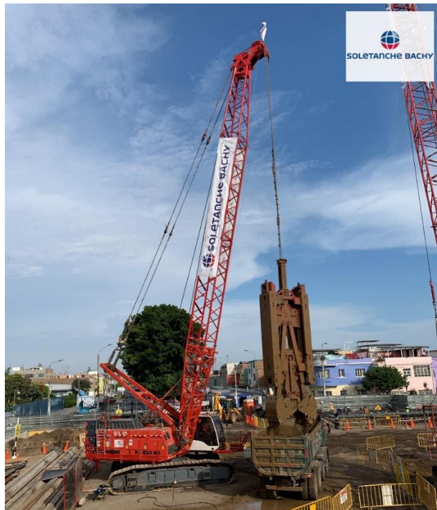
Figura N°4.9 Eliminación de material excedente procedente de la excavación en volquete.
