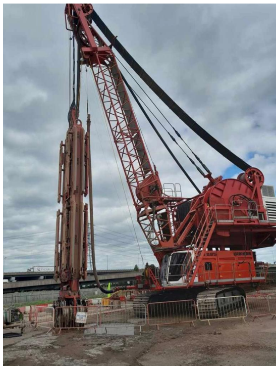
Figura N°2.8 Hidrofresa. Fuente: Elaboración propia.
