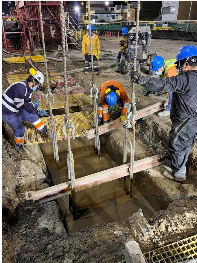
Figura N°4.31 Colocación de vigas para suspender armadura.
