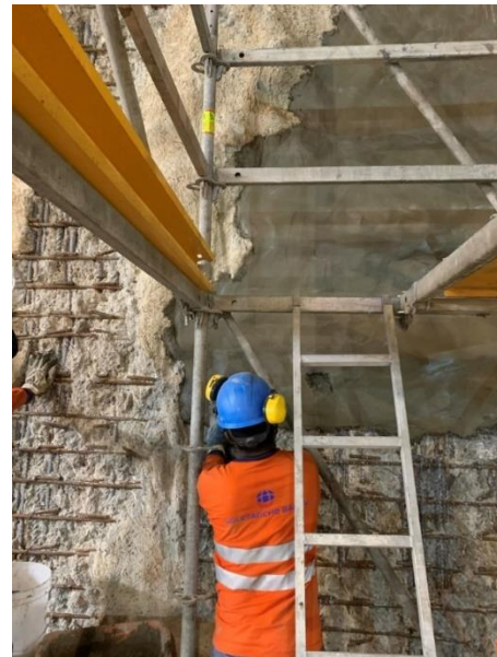
Figura N°4.53 Empaste de muros diafragma con Sika Rep
