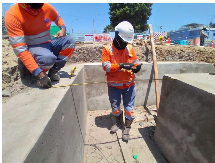
Figura N°4.4 Verificando que el muro guía se encuentre alineado y con el ancho correspondiente.
