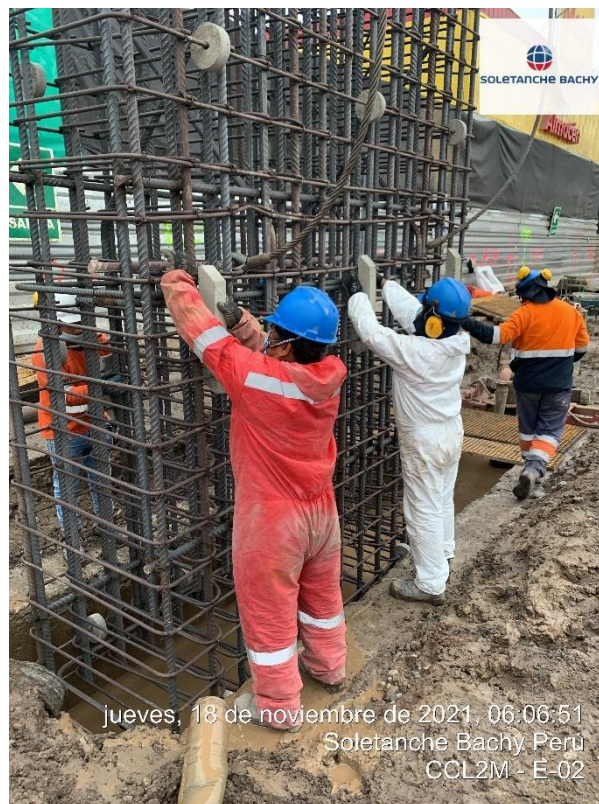
Figura N°4.30 Colocación de separadores trapezoidales.
