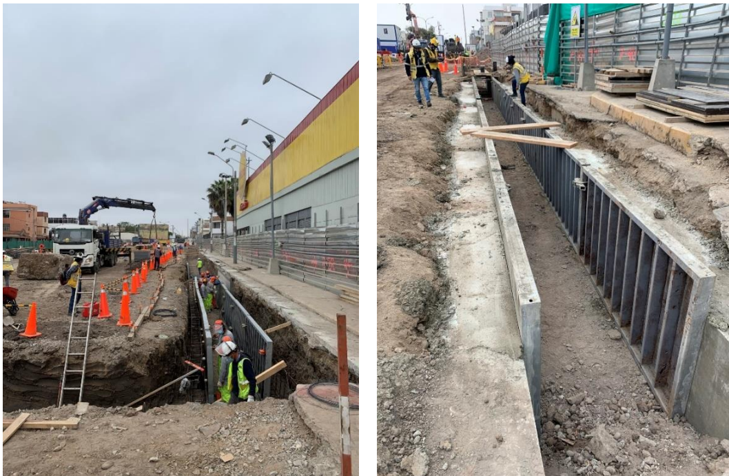
Figura N°4.1 Encofrado y desencofrado de muro guía.
