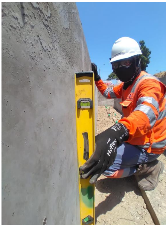
Figura N°4.3 Verificando que la superficie de muro guía este aplomada.
