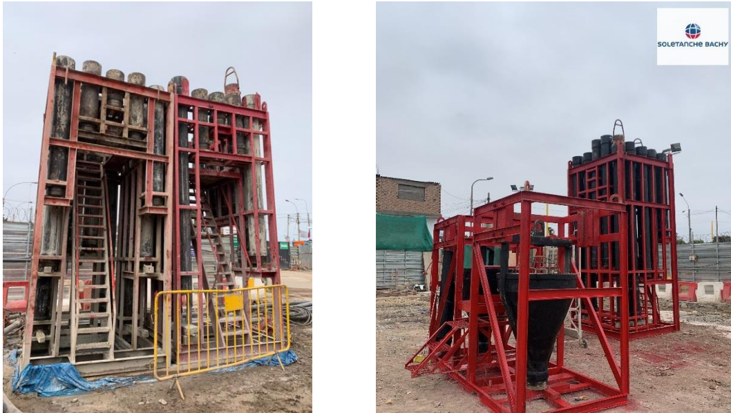
Figura N°4.35 Racks con tubería tremie y embudos.
