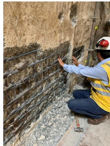
..... Figura N°4.51 Limpieza con escobilla metálica y soplete de aire (a la izquierda), liberación por el supervisor de calidad (a la derecha)
