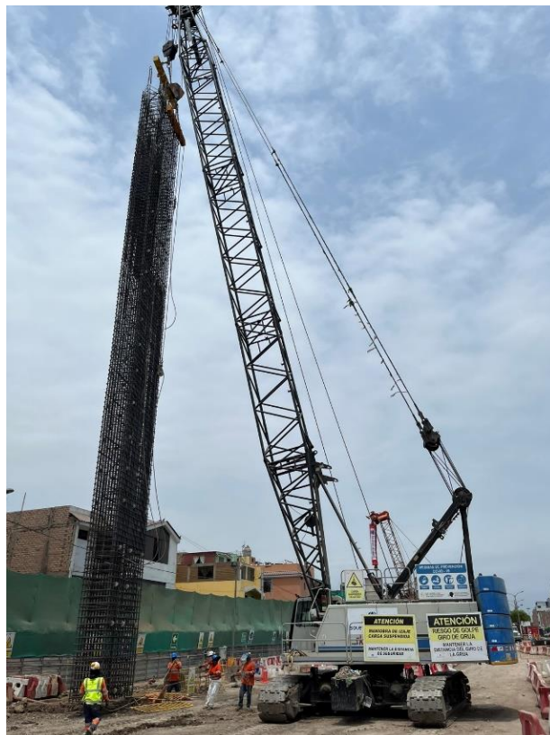
Figura N°4.29 Verticalización de armadura.
