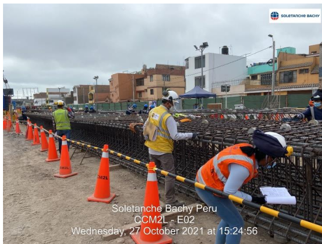
Figura N°4.33 Inspección de armaduras por parte de los supervisores.
