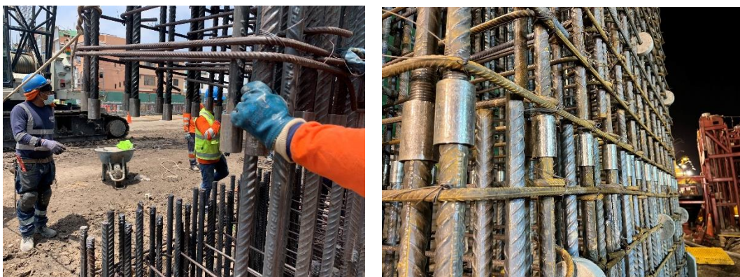
Figura N°4.32 Empalme de armadura mediante conectores mecánicos.
