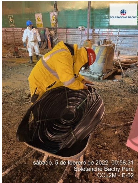
Figura N°4.25 Verificación de las condiciones del wáter-stop a colocar.
