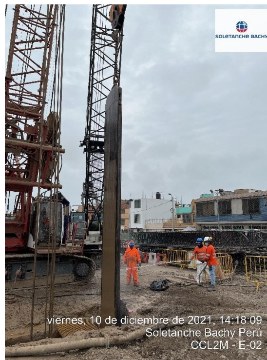
Figura N°4.24 Extracción de junta metálica trapezoidal.
