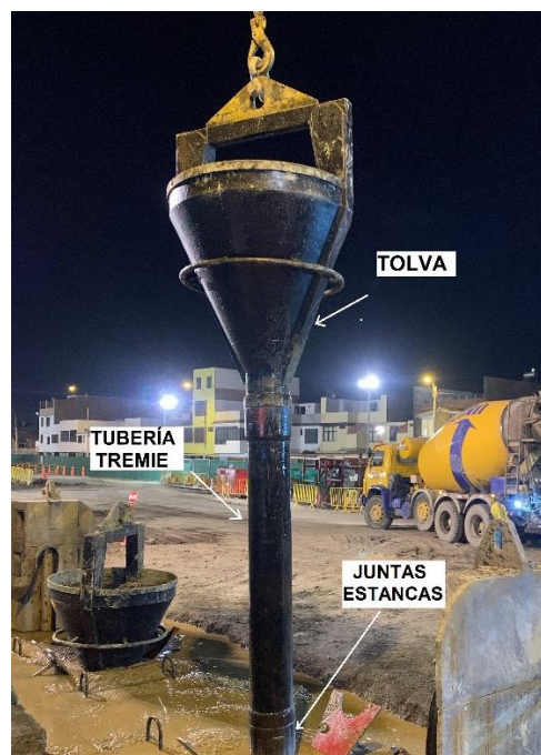
Figura N°2.5 Línea de tubería tremie.
