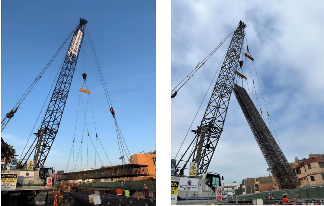
Figura N°4.28 Maniobra de izaje de armadura.
