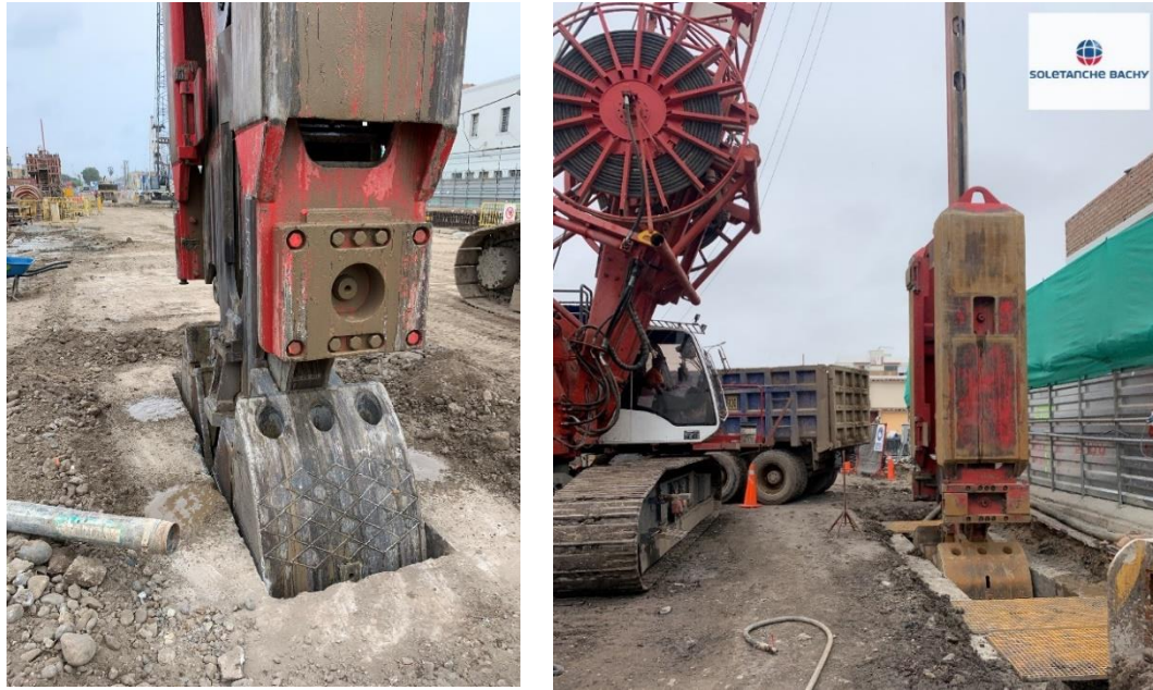
Figura N°4.7 Excavación de panel de una posición (izquierda) y de dos posiciones (derecha).
