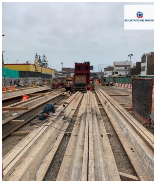
Figura N°2.3 Juntas trapezoidales de 1140mm.
