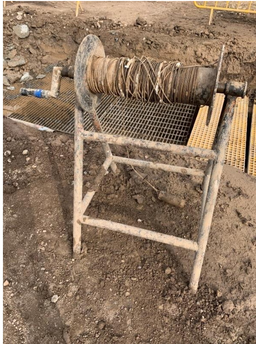
Figura N°4.10 Sonda de cable para medir la profundidad de la excavación.
