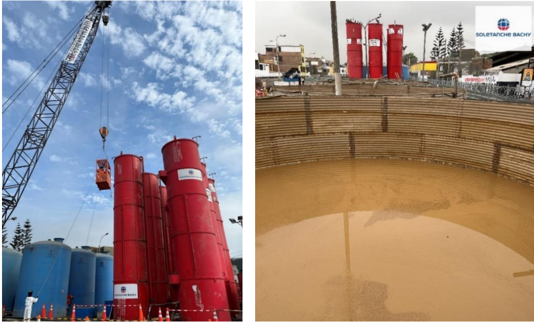
Figura N°2.11 Tanques de almacenamiento de agua, silos (izquierda) y tanques australianos para almacenamiento de fluido de perforación (derecha).
