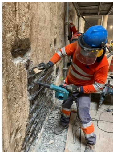
..... Figura N°4.51 Limpieza con escobilla metálica y soplete de aire (a la izquierda), liberación por el supervisor de calidad (a la derecha)
