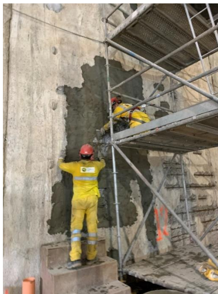
Figura N°4.53 Empaste de muros diafragma con Sika Rep
