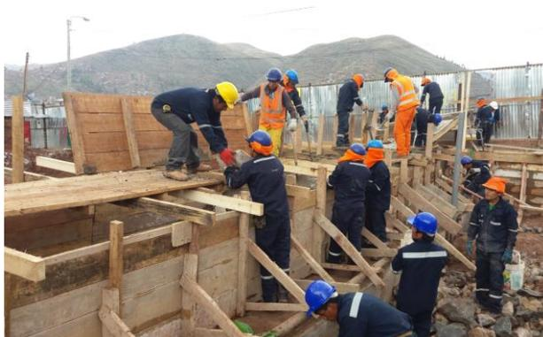
Figura N° 4. Madera en encofrados.
