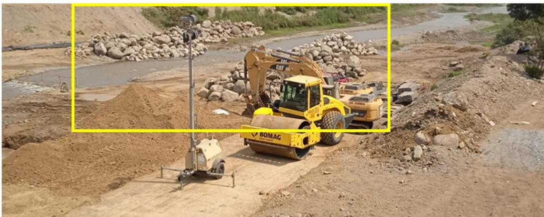
Figura N°28: Material de enrocado acopiado, aguas arriba
