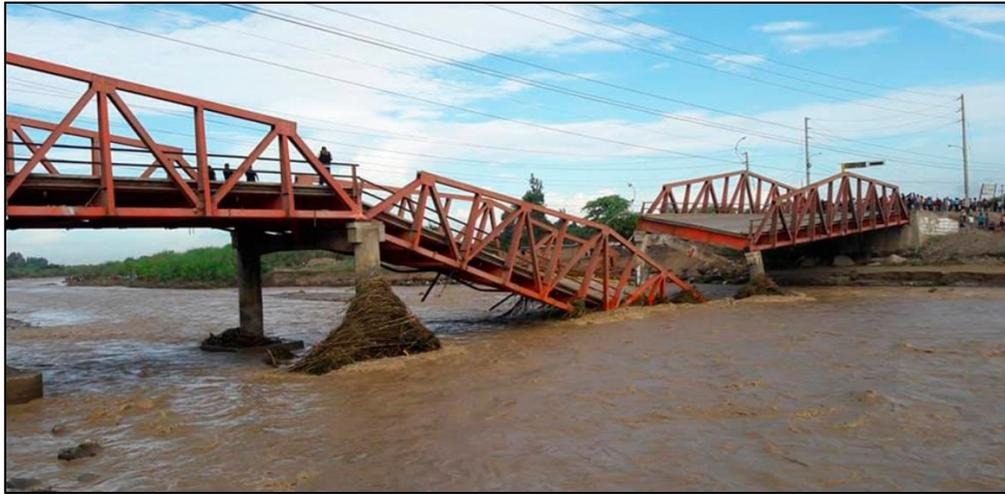
Figura N°8: Puente Virú colapsado, Fenómeno del Niño Costero 2017.
