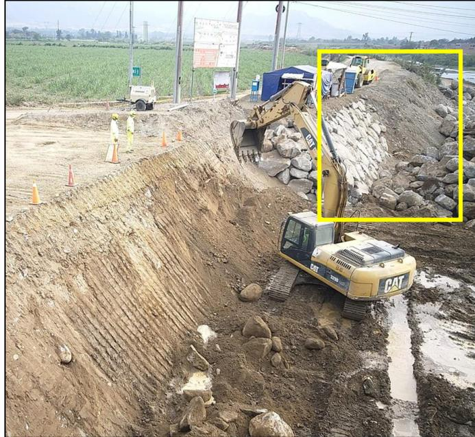
Figura N°40: Transición de enrocado, margen derecha, aguas arriba.
