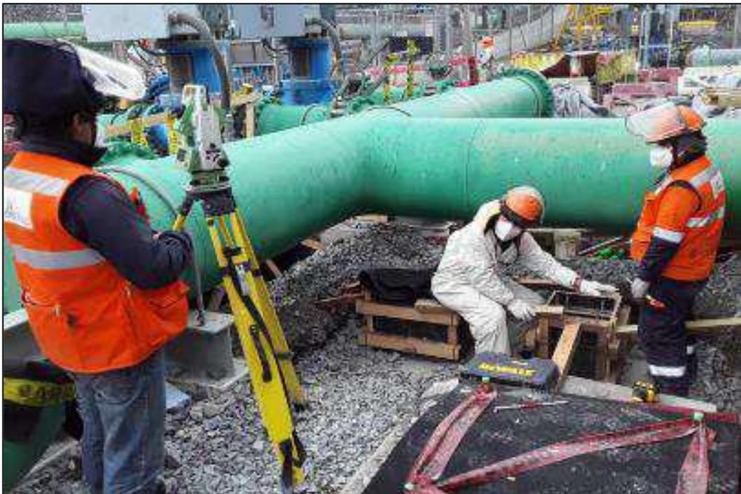
**Figura N° 3.4 Replanteo de cotas topográficas**
