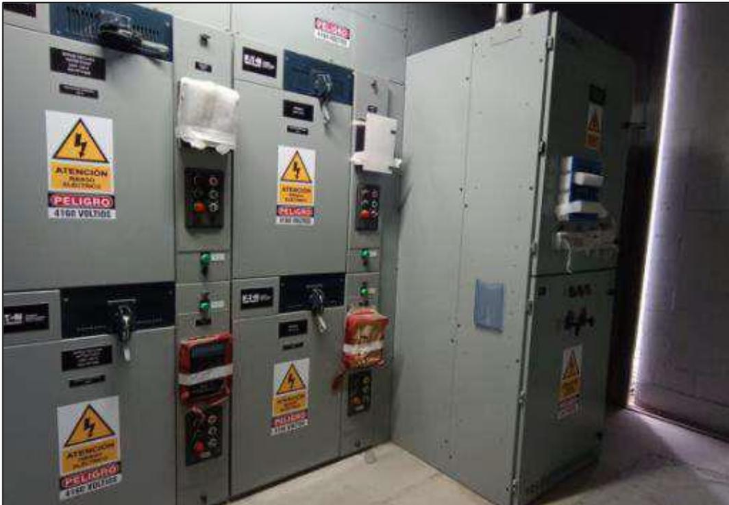
**Figura N° III.6 Centro de control de motores**
