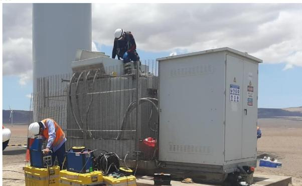
La potencia del transformador se dimensiona en función de las características del convertidor asociado al aerogenerador. La potencia del transformador se diseña a la condición más desfavorable de regulación de tensión, para el convertidor equivalente al 0.95 p.u. de su potencia nominal.
