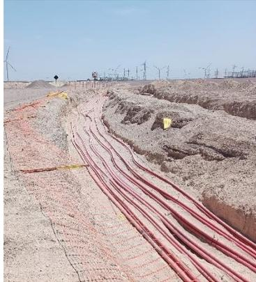
La instalación de estos cables subterráneos se lleva a cabo dentro de zanjas con características y dimensiones específicas (ver figura 5), se busca que la longitud del cable sea mínima, utilizando trayectos rectos para evitar ángulos agudos y facilitar el acceso.
