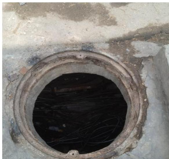
7. Para ello luego de instalar la caja de 256 fibras se repuso la tapa a la cámara y se selló la cámara para evitar accidentes y corte de los cables por robo de cobre.
