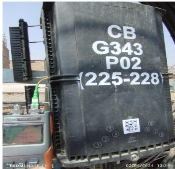
10. En el CTO tiene un *splitter* 1x2 proveniente del Hub Box y en cadena de otro CTO. Máximo se puede tener una cadena de 3 CTO por la atenuación que se pueda dar en cada ramal. En las siguientes imágenes se mostrarán las potencias de ingreso y salida a los clientes.
