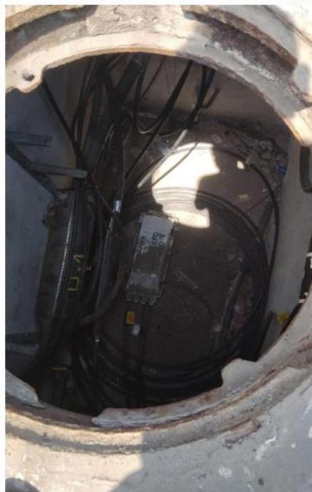
7. Los cableados ingresan a la caja de empalme de 256 fibras, que se fusionan con cables de 32 fibras para el ingreso de máximo 8 *Hub Box*.
