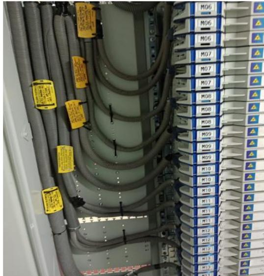
6. Los cableados alimentadores que ingresan son de 256 fibras. Dichos cables van por parte subterránea entre cámaras que llegan al punto donde va a ingresar hasta la caja de empalme.
