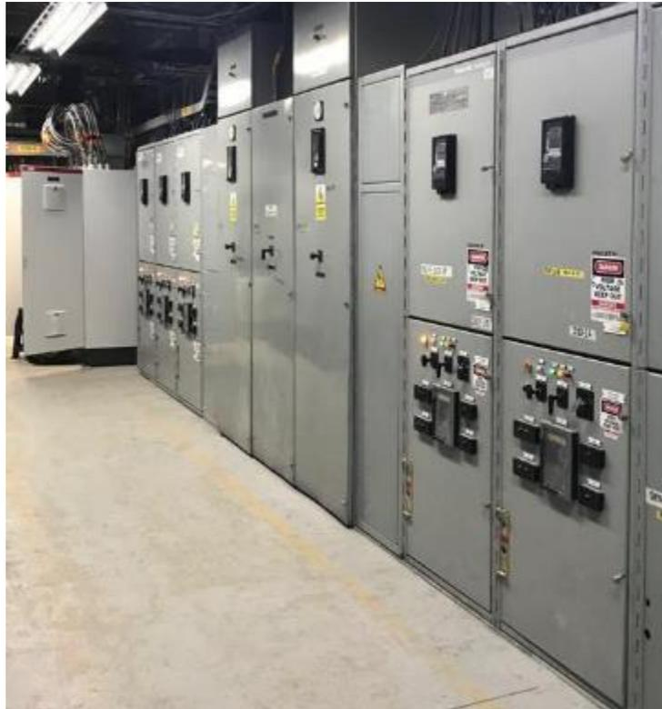
**3.1.4.5 Equipos o aparatos de maniobra.** Los equipos de maniobra son Interruptores o Circuit Breakers con los que se realiza el arranque o parada de los motores. Estos se encuentran ubicados en los tableros de MT y realizan la función de apertura y cierre del circuito de alimentación del motor.
