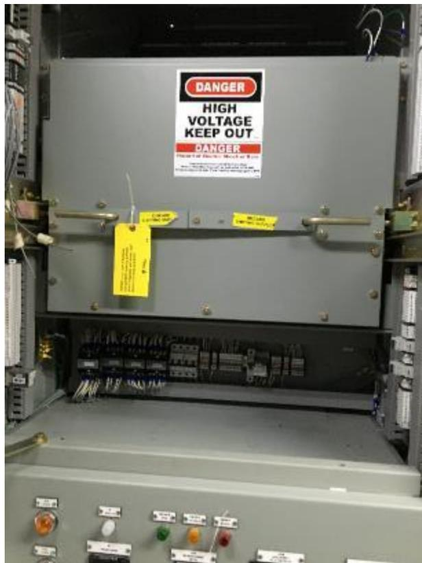
**3.2.5.5.3 Compartimiento de Cables de energía.** El compartimiento para conexión de cables de salida para alimentación de los motores, se encuentran ubicados en la parte posterior del tablero y se accede retirando las tapas o cubiertas que son empernadas. Ver plano N° en Anexos.
