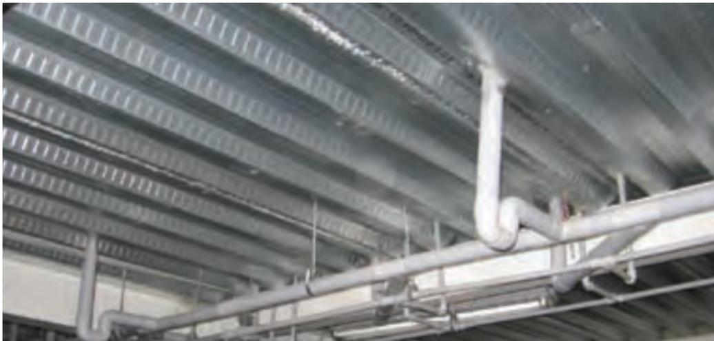
FIGURA N° 3.33: Instalación de tuberías por debajo de losas colaborantes.
