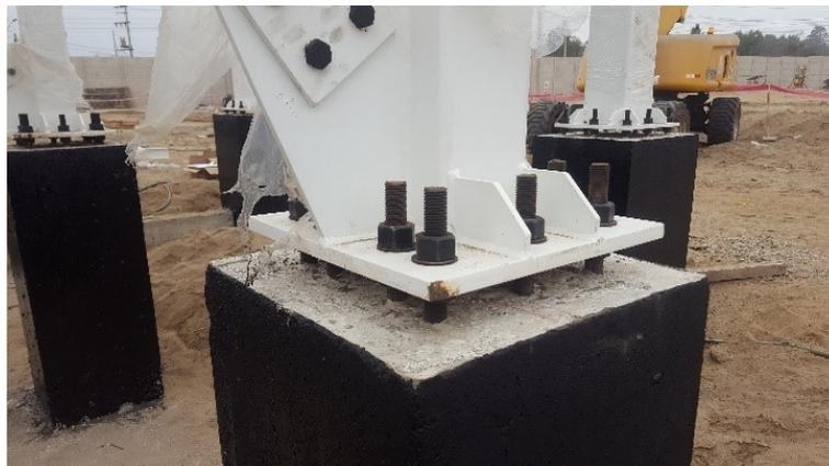
FIGURA N° 3.1: Unión de columna de metal con columna de concreto - Edificación con estructuras metálicas. Fuente: Propia
