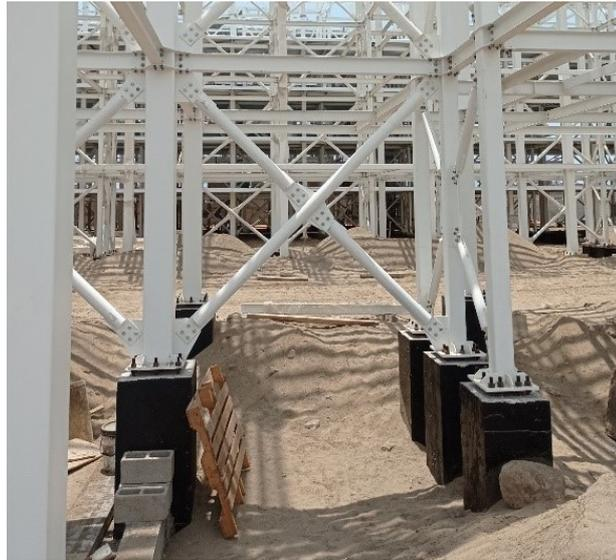
FIGURA N° 3.2: Pórtico concéntricamente arriostrado - Edificación con estructuras metálicas.
