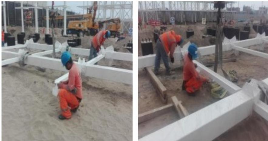
FIGURA N° 4.24: Resane de pintura de estructuras metálicas. Fuente: Propia
