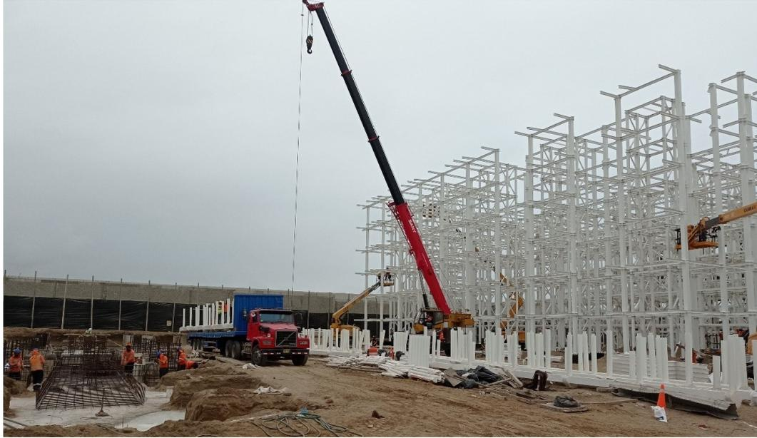
FIGURA N° 3.21: Descarga y almacenamiento de estructuras metálicas a pie de su montaje.
