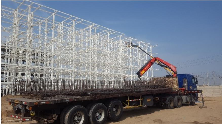
FIGURA N° 4.21: Llegada a obra de parrilla inferior de zapatas - armadura prearmada soldada en Torre 1. Fuente: Propia
