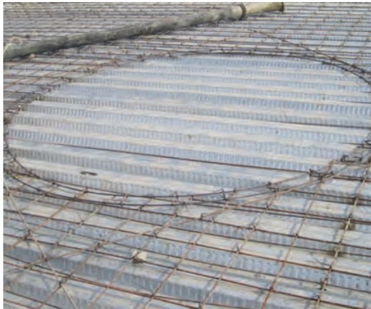
FIGURA N° 4.27: Acero de refuerzo en ducto. Fuente: Aceros Procesados S.A. (2021)
