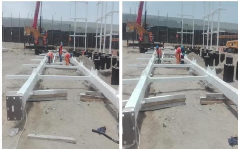
FIGURA N° 4.26: Armado 2D en el suelo de las estructuras metálicas. Fuente: Propia
