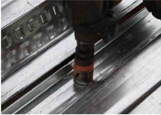
(a) Perforación de placas con broca socabocado.
