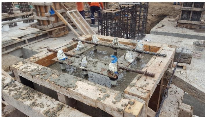
FIGURA N° 4.17: Pernos embebidos en pedestal con concreto fresco en Torre 1. Fuente: Propia
