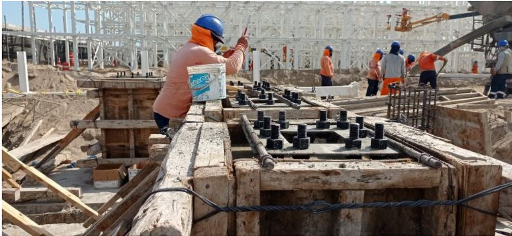
FIGURA N° 4.23: Pernos sujetos por toperas soldadas a la placa modelo.
