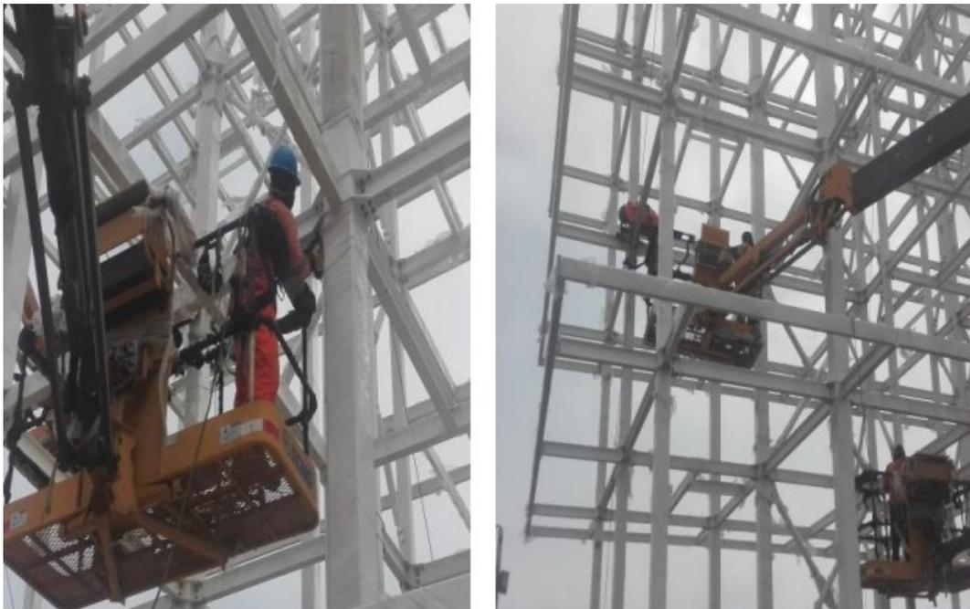
FIGURA N° 4.18: Ajuste de pernos con pistola de impacto en Torre 1. Fuente: Propia
