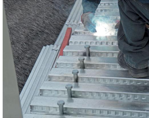
(b) Soldadura de conectores de corte.
