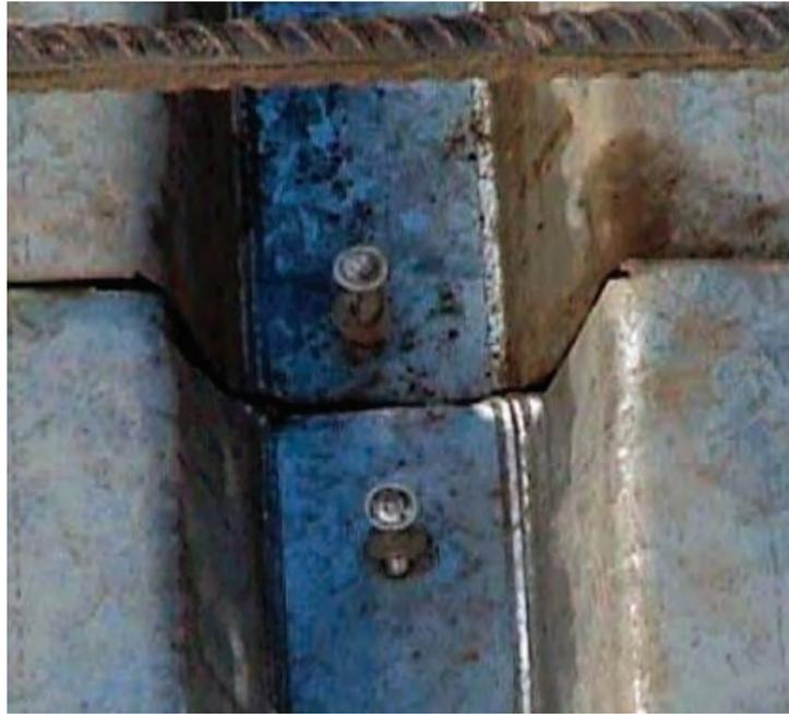
FIGURA N° 3.30: Fijación de placas colaborantes con pernos auto perforantes.
