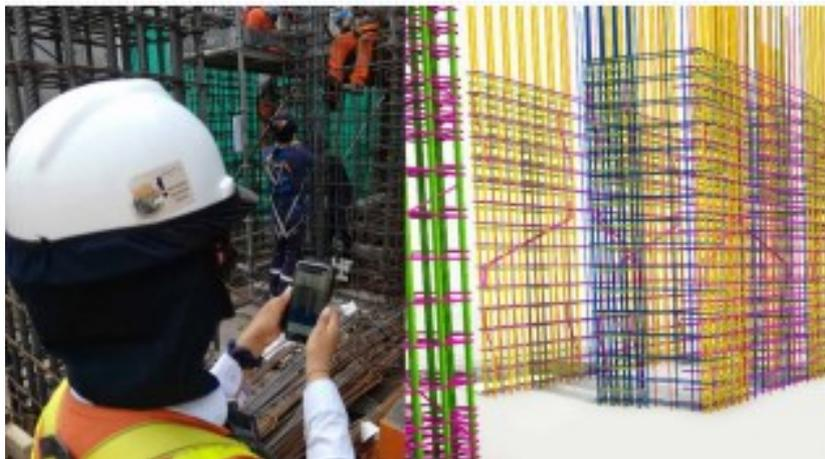
FIGURA N° 3.14: Colocación de armadura prefabricada verificada con apoyo del modelo BIM.
