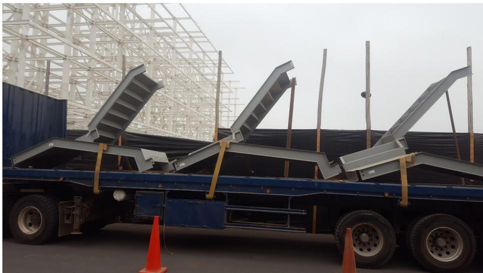
FIGURA N° 3.20: Transporte de escalera metálica. Fuente: Propia
