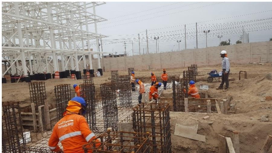
FIGURA N° 4.22: Colocación de la armadura prearmada - ACEDIM. Fuente: Propia
