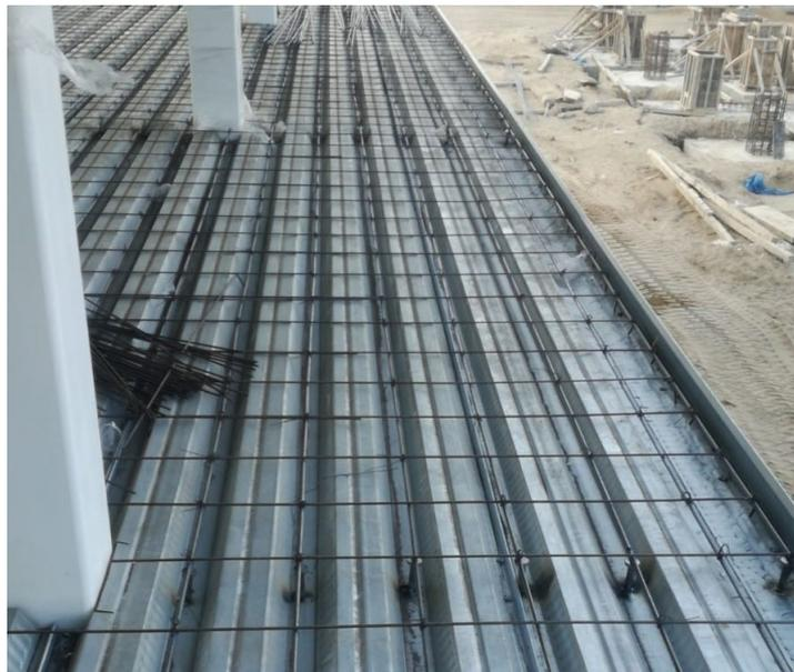
FIGURA N° 4.19: Conectores de corte colocados en Torre 1. Fuente: Propia
