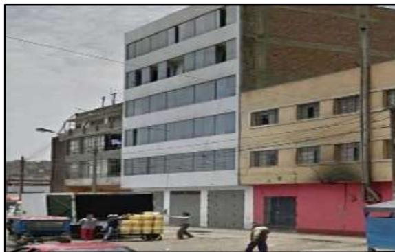
Figura N° 22: Edificación analizada de La Victoria. Adaptado de Google Maps (2020).
