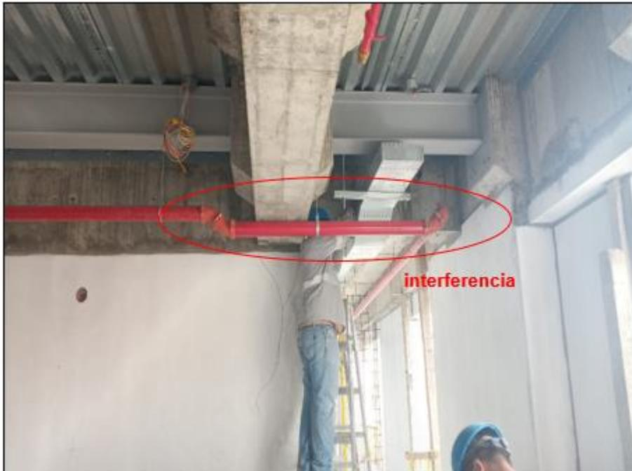
*Nota.* En la figura se aprecia las interferencias entre el SCI, con la viga peraltada y la canaleta eléctrica. Fuente: Fotografía tomada de la obra.
