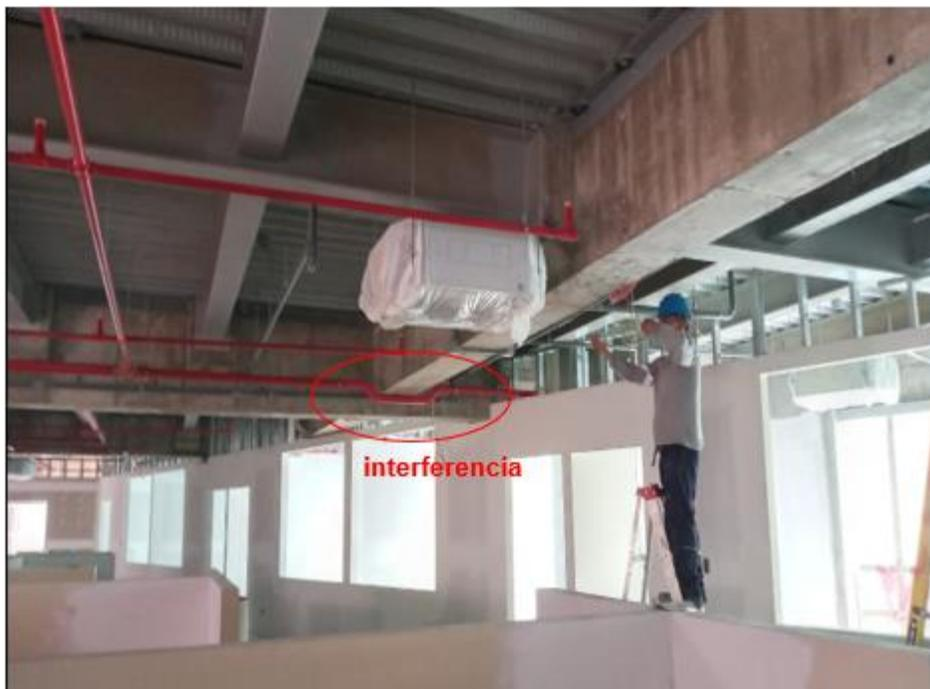
*Nota.* En la figura se aprecia las interferencias entre las redes del SCI, con viga peraltada. Fuente: Fotografía tomada de la obra.
