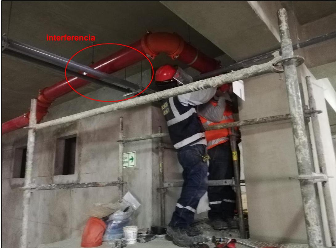
*Nota.* En la figura se aprecia la interferencia entre las tuberías del SCI con tubería de agua potable. Fuente: Fotografía tomada de la obra.
