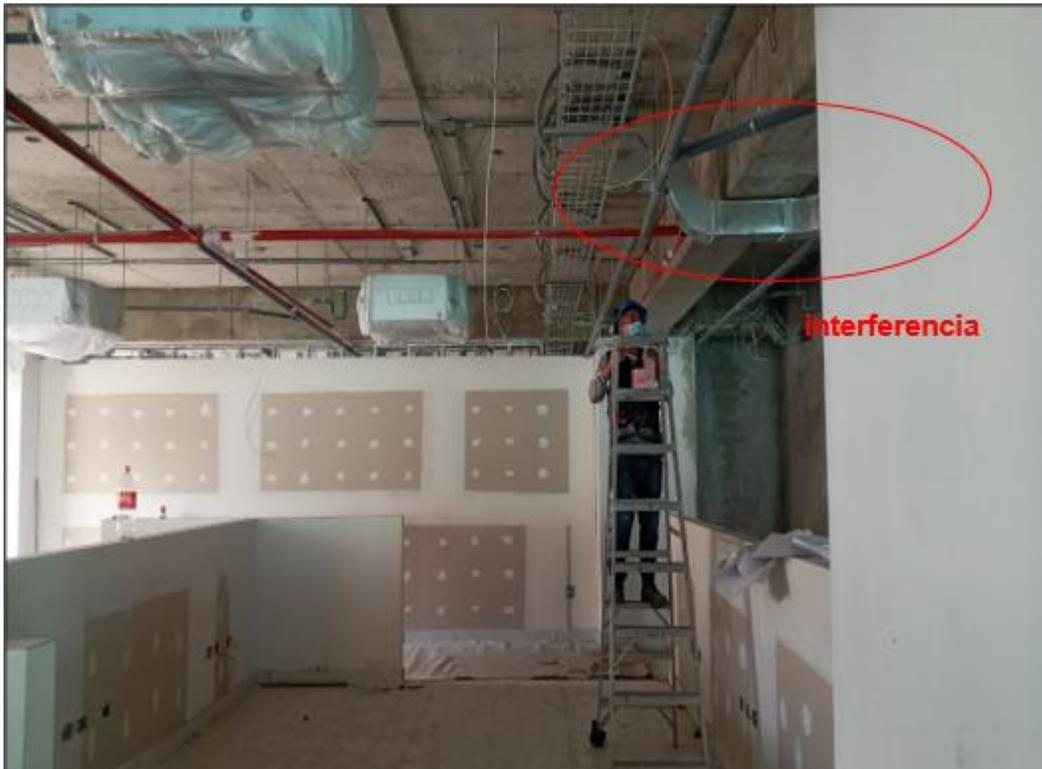
*Nota.* En la figura se aprecia la interferencia entre las bandejas eléctricas con la viga estructural. Fuente: Fotografía tomada de la obra.
