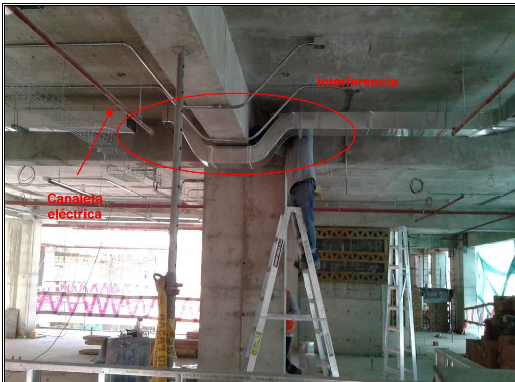
*Nota.* En la figura se aprecia la colisión entre instalaciones mecánicas, eléctricas y viga peraltada. Fuente: Fotografía tomada de la obra.
