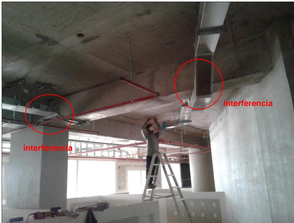
*Nota.* En la figura se aprecia la interferencia entre el ducto metálico para ventilación con viga peraltada. Fuente: Fotografía tomada de la obra.
