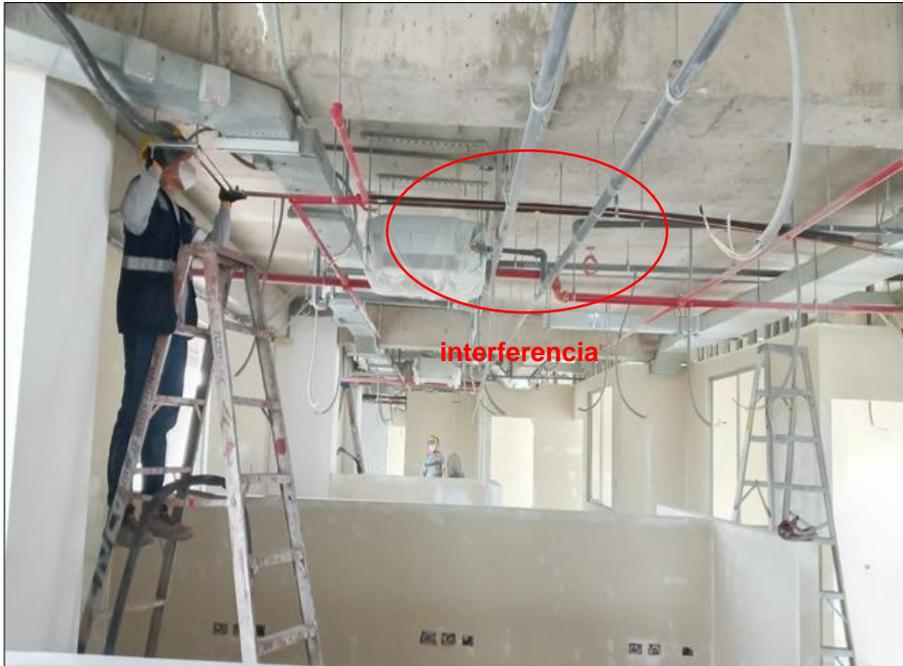
*Nota.* En la figura se aprecia la Interferencia entre líneas de refrigeración, con SCI y desagüe. Fuente: Fotografía tomada de la obra.
