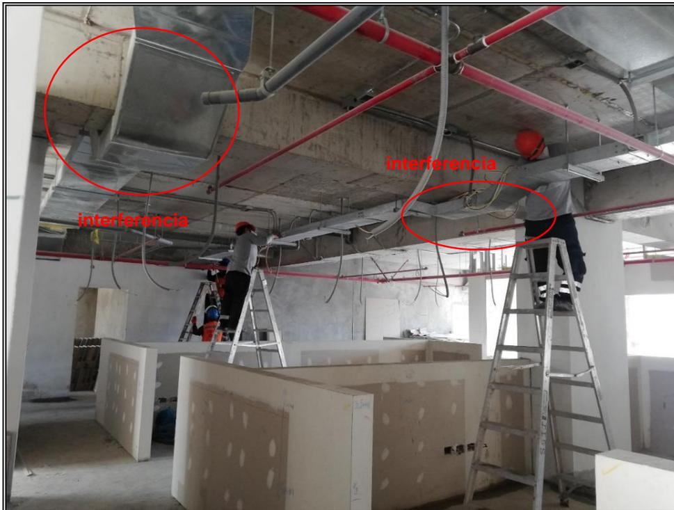
*Nota.* En la figura se aprecia la colisión entre la ventilación mecánica, la viga peraltada y el SCI. Fuente: Fotografía tomada de la obra.
