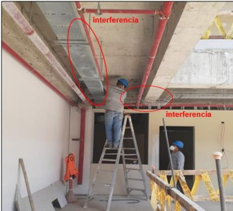
*Nota.* En la figura se aprecia la interferencia entre las líneas de refrigeración con el SCI. Fuente: Fotografía tomada de la obra.
