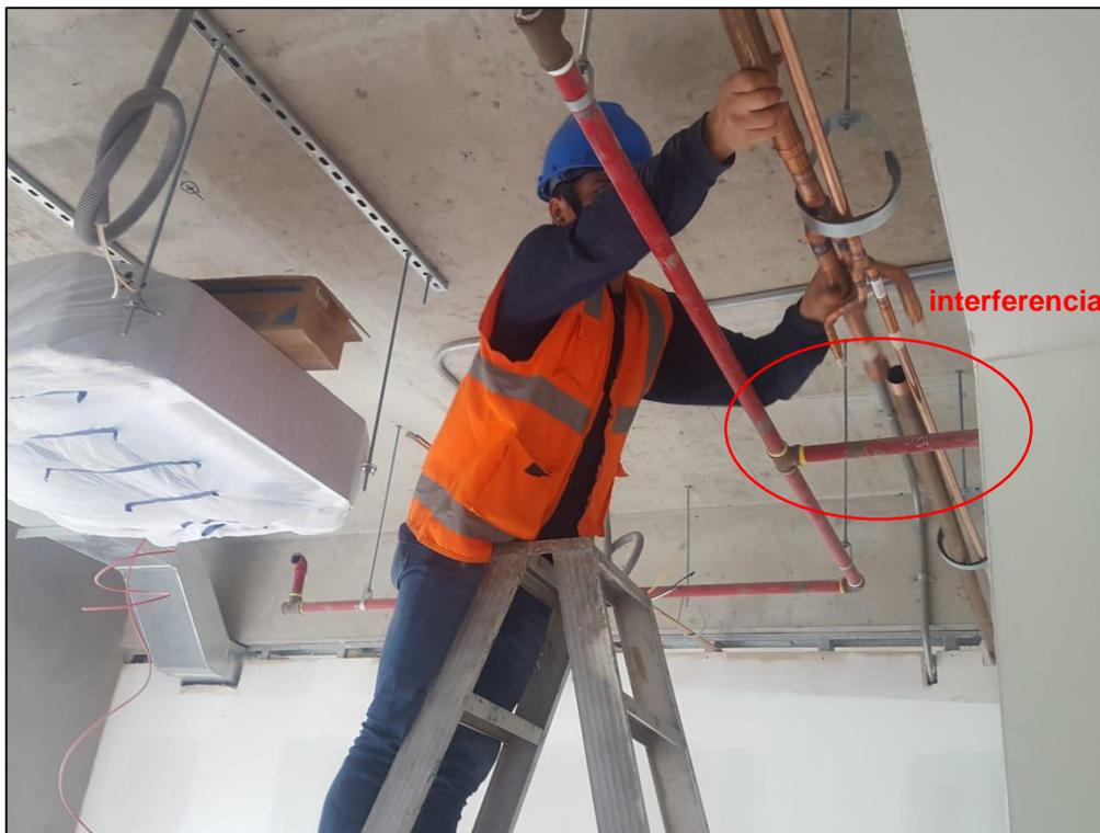
*Nota.* En la figura se aprecia la colisión entre las líneas de refrigeración con el SCI. Fuente: Fotografía tomada de la obra.
