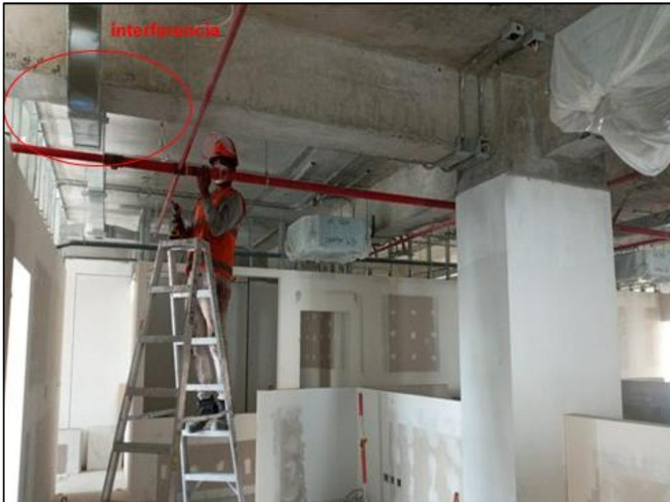
*Nota.* En la figura se aprecia la interferencia entre la bandeja eléctrica y las redes del SCI. Fuente: Fotografía tomada de la obra.
