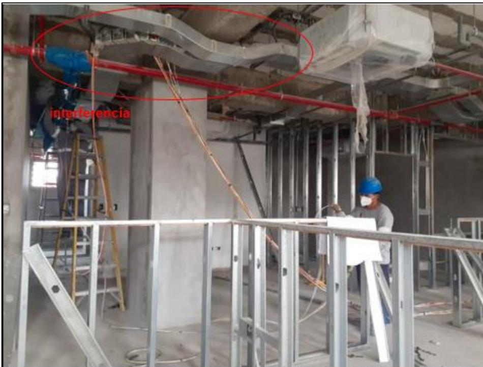
*Nota.* En la figura se aprecia las interferencias entre la viga peraltada con el SCI y bandejas eléctricas. Fuente: Fotografía tomada de la obra.
