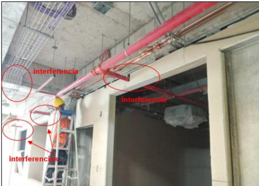
*Nota.* En la figura se aprecia las interferencias del SCI, con el dintel y líneas de refrigeración. Fuente: Fotografía tomada de la obra.
