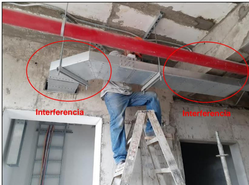
*Nota.* En la figura se aprecia la colisión entre bandejas eléctricas con dintel estructural. Fuente: Fotografía tomada de la obra.
