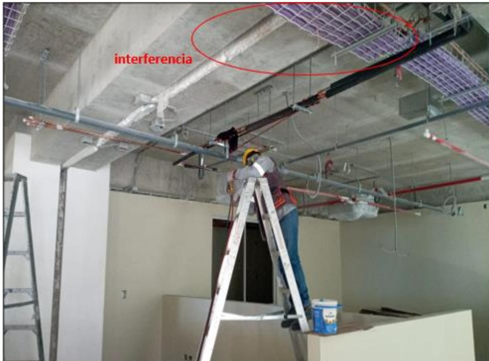
*Nota.* En la figura se aprecia la interferencia entre líneas de refrigeración, bandejas eléctricas y el SCI. Fuente: Fotografía tomada de la obra.
