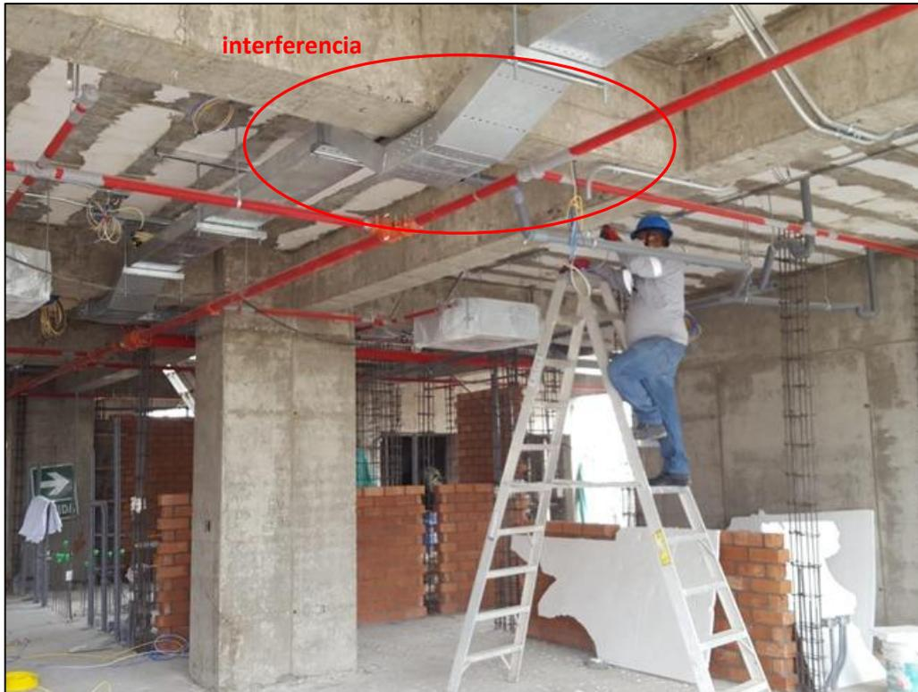
*Nota.* En la figura se aprecia la Interferencia entre la bandeja eléctrica y la viga peraltada. Fuente: Fotografía tomada de la obra.
