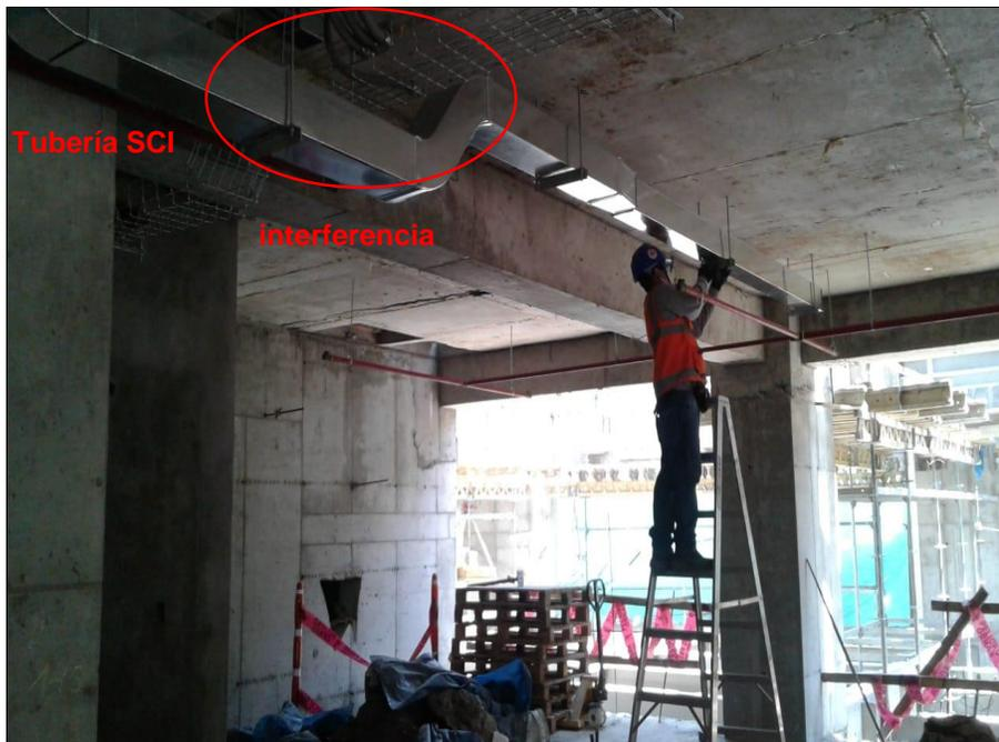
*Nota.* En la figura se aprecia la colisión entre ducto de ventilación mecánica con bandeja eléctricas. Fuente: Fotografía tomada de la obra.
