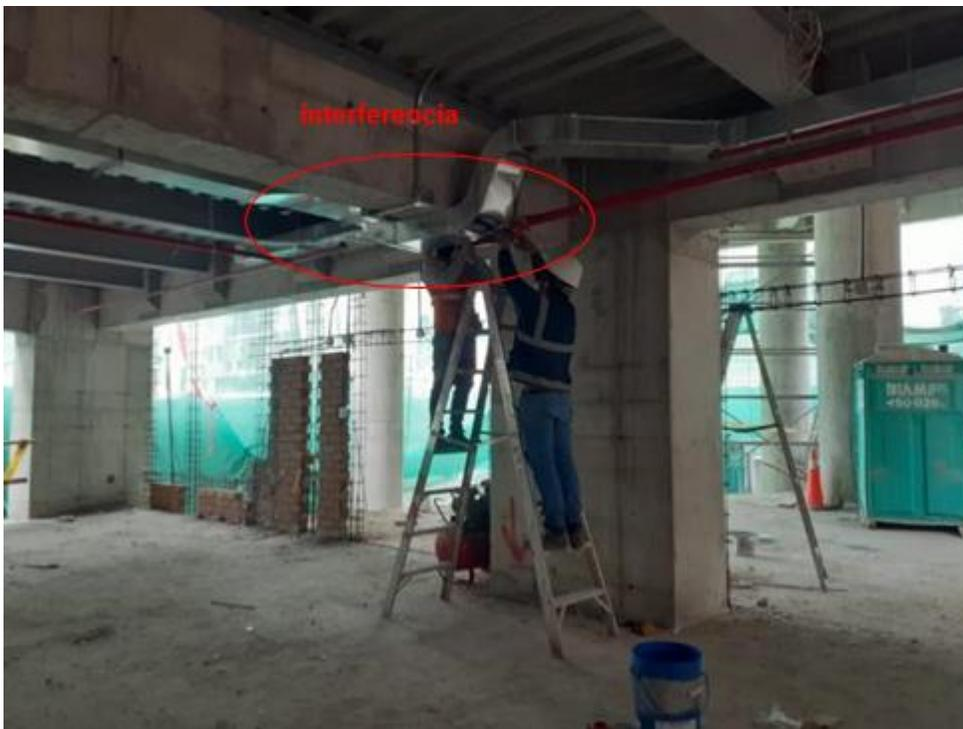
*Nota.* En la figura se aprecia la interferencia entre la ventilación mecánica y la viga peraltada. Fuente: Fotografía tomada de la obra.
