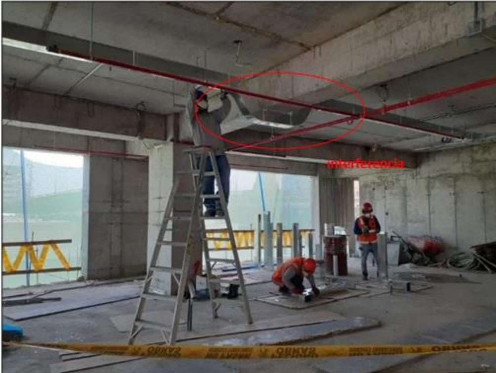
*Nota.* En la figura se aprecia la Interferencia entre la ventilación mecánica con viga peraltada. Fuente: Fotografía tomada de la obra.
