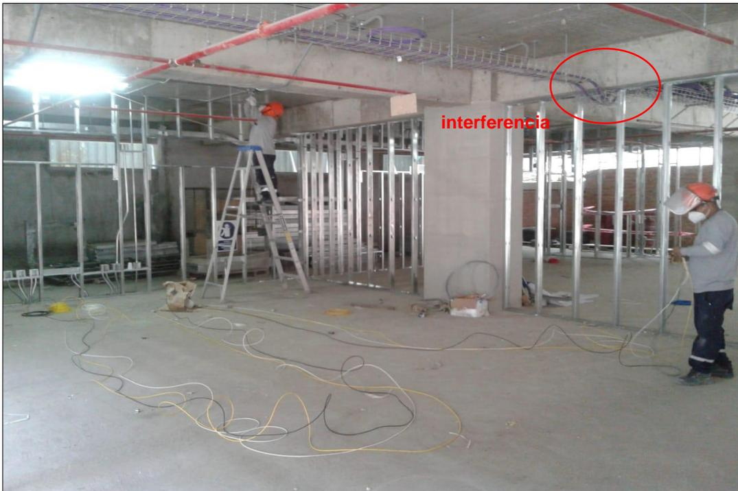
Nota. En la figura se aprecia la interferencia entre la bandeja eléctrica y la viga peraltada. Fuente: Fotografía tomada de la obra.
