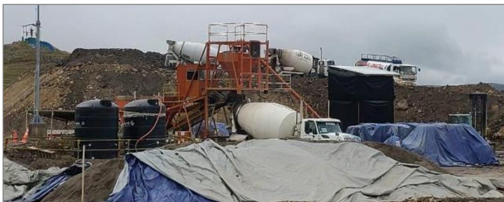
**Dic-20, CPI = 1.18:** con la planta de concreto operativa y frente de trabajo, se trabajó con horario extendido produciendo 1,283 m<sup>3</sup>. Además, se tuvo un mayor rendimiento (10 m<sup>3</sup>/hr real vs 8 m<sup>3</sup>/hr presupuesto), lo que generó un CPI mayor a 1, al igual que en los meses de Ene-21 y Feb-22.
