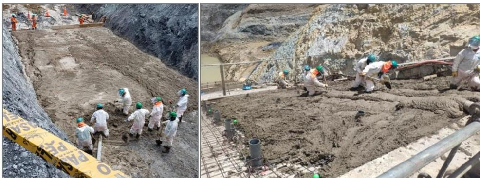
**Dic-20, CPI = 0.81:** se tuvo un mayor avance de la partida, dado que se implementó una segunda bomba de concreto y se tuvieron mayores costos de tubería y accesorios. Además, por las condiciones climáticas se utilizó los microclimas y calefactores, que no fueron considerados en el presupuesto. A pesar del avance de 1,283 m<sup>3</sup> se tuvo un CPI menor a 1.
