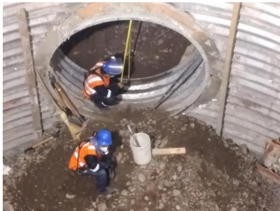
Figura N° 2.9 Colocación de láminas Linner
