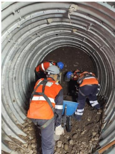
Figura N° 2.13 Excavación de túnel horizontal
