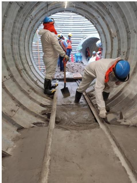
Figura N° 2.15 Colocación de solado e instalación de rieles
