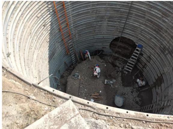
Figura N° 2.8 Excavación de primer anillo horizontal
