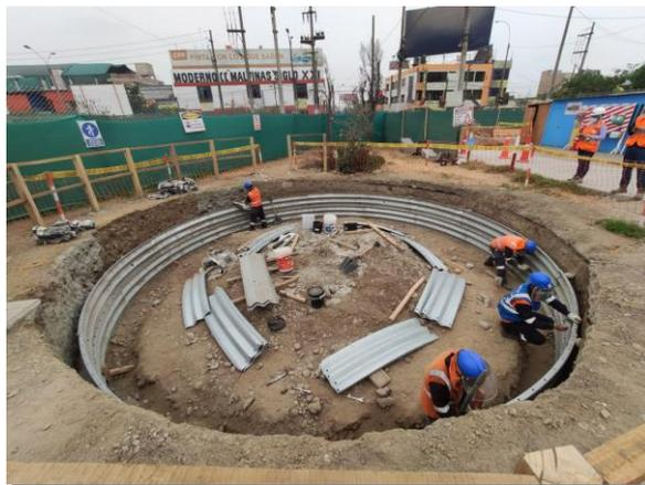
Figura N° 2.4 Colocación de láminas Linner
