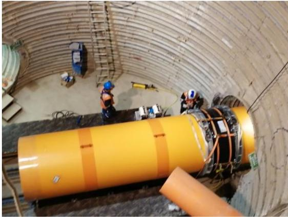
Figura N° 2.17 Electrofusión de tuberías HDPE
