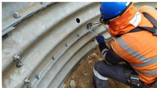
Figura N° 2.5 Colocación de pernos
