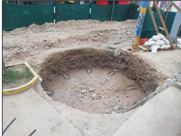
Figura N° 2.3 Excavación de túnel vertical
