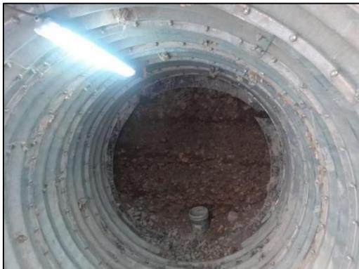
Figura N° 2.11 Instalación de luminarias
