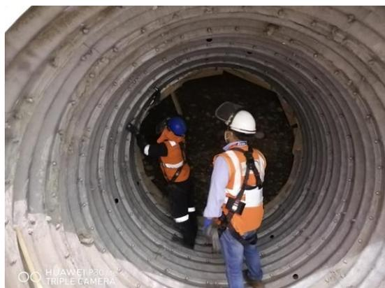
Figura N° 2.10 Colocación de pernos
