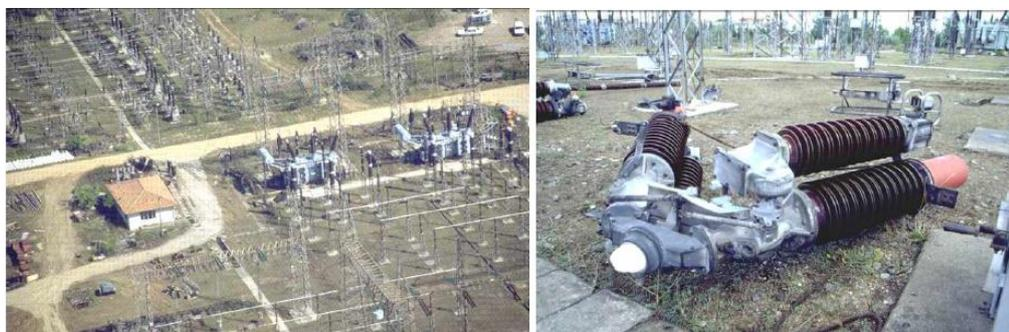
**Figura 92.** Colapso de redes eléctricas tras el terremoto, refinería Tupras.
