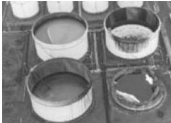
**Figura 42.** Colapso de techo flotante en tanques en terremoto Tokachi Oki (2003).
