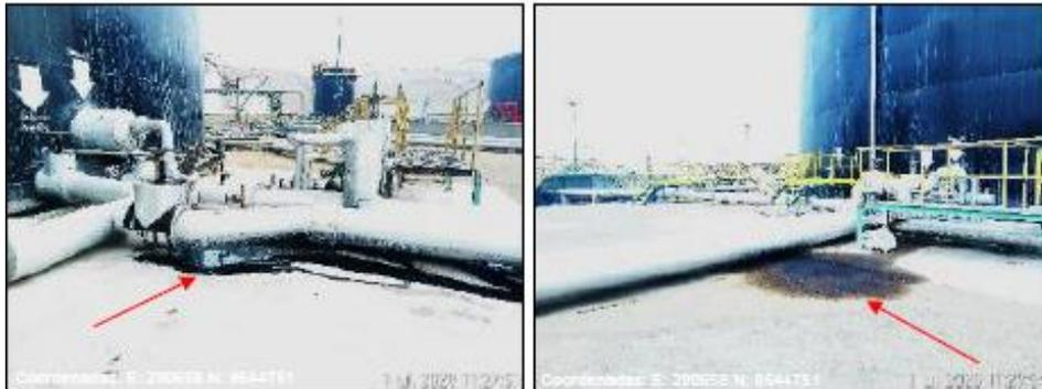
**Figura 89.** Goteo de hidrocarburos en unión de válvulas y tuberías.
