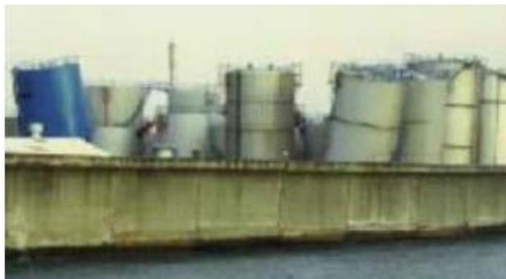
**Figura 44.** Fallas de tanques por asentamiento, terremoto Kobe 1995.
