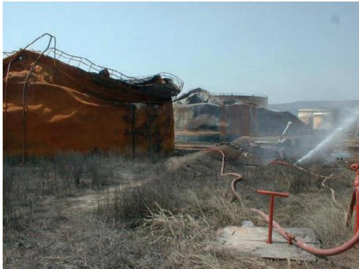
**Figura 102.** Incendio de tanques dañados por terremoto, refinería Izmit (1999).
