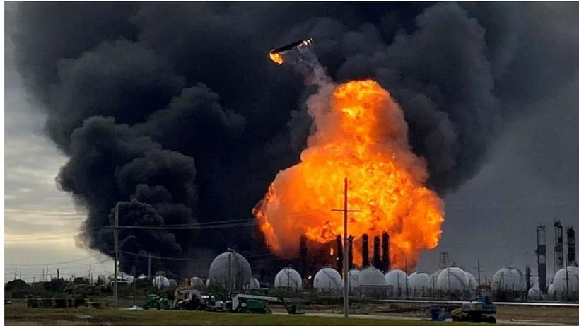
**Figura 104.** Expansión explosiva BLEVE en tanque.
