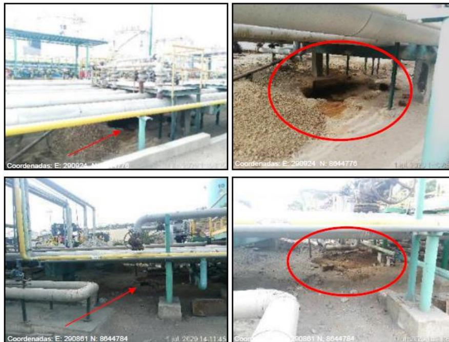
**Figura 91.** Manchas de hidrocarburos en zona de rack de tuberías.
