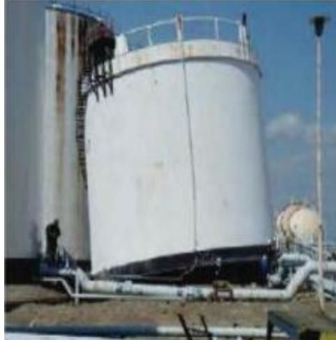
**Figura 43.** Deslizamiento de tanques por fuerza sísmica.
