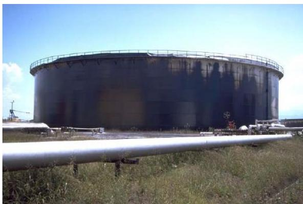
**Figura 99.** Derrame por rebose por chapoteo de fluido.
