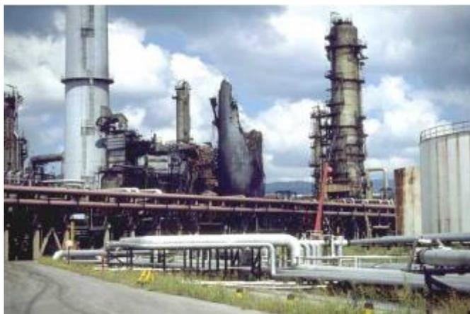
**Figura 60.** Falla de horno en refinería Tupras.
