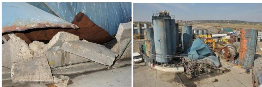
**Figura 68.** Detalle de fallo de muro estanco de un tanque.
