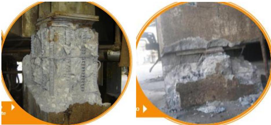
**Figura 59.** Fallas en bases de hornos, refinería ENAP Chile, terremoto de 2010.
