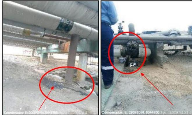
**Figura 88.** Fugas por fallo en base de tuberías.
