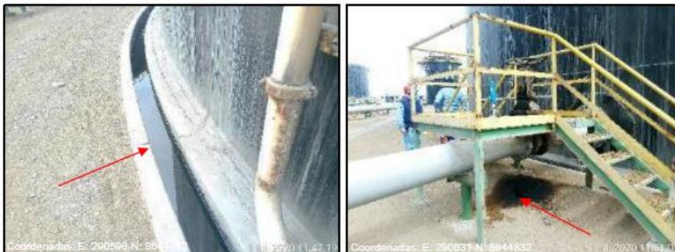
**Figura 90.** Fuga de hidrocarburos en válvula de tanque 74.
