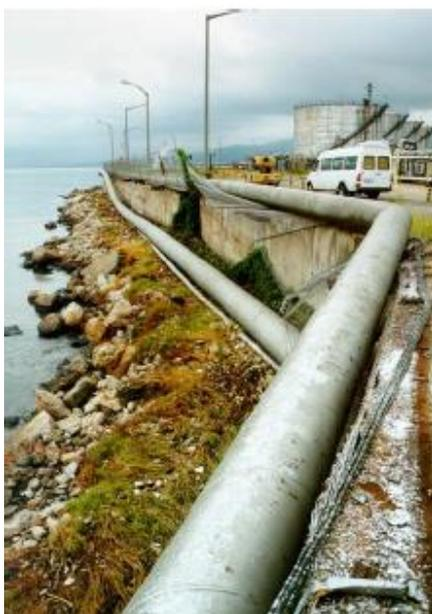
**Figura 77.** Falla de tubería continua, refinería Tupras.
