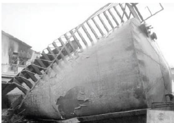
**Figura 45.** Volcamiento de tanque en refinería RECOPE, Costa Rica, 1991.
