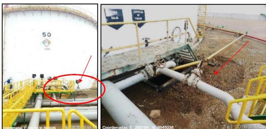
**Figura 87.** Manchas de hidrocarburos en unión de tuberías con tanques.
