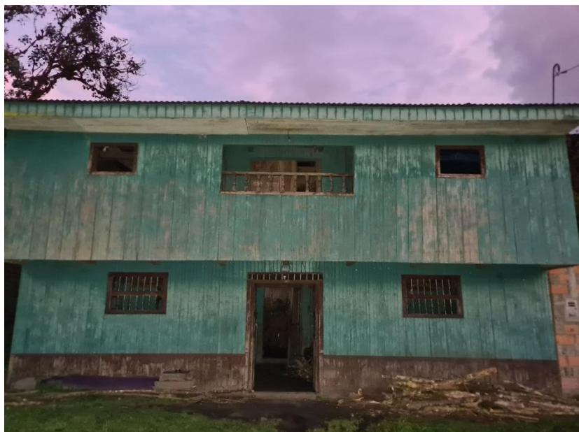
El panel posterior a la fachada presenta típicamente menos aberturas. Suponiendo una longitud entablada de 7 metros y por ende 35 elementos, el momento resistente del panel posterior en el segundo piso de la vivienda ( $M_{R1}^2$ ) sería estimado como:
