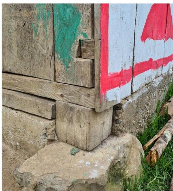
Las viviendas suelen estructurarse en dos paneles, denominación que se le asigna a la unión de columnas y vigas, en la dirección transversal (Ver la figura 29). Asimismo, las conexiones entre los elementos estructurales se realizan únicamente utilizando clavos de alambre.
