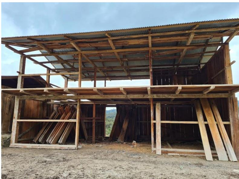
Dicho sistema suele ser muy flexible y economiza la mano de obra por presentar menor número de elementos a ensamblar respecto al sistema de entramados. Sin embargo, este sistema requiere elementos diagonales en muros para proporcionar mayor estabilidad lateral (PADT-REFORT, 1984).
