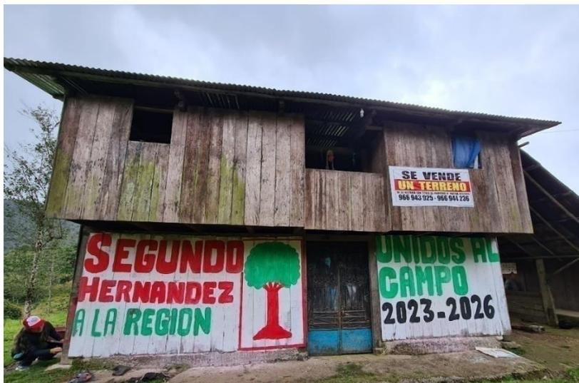
Las viviendas generalmente tienen uno o dos niveles. Están apoyadas en el terreno mediante bloques de piedra o concreto en forma de cimientos. De donde parten las columnas de madera que soportan los entrepisos y techo. En los anexos se muestra un panel fotográfico de las viviendas estudiadas en este trabajo, sus dimensiones generales y las de los elementos que las constituyen.
