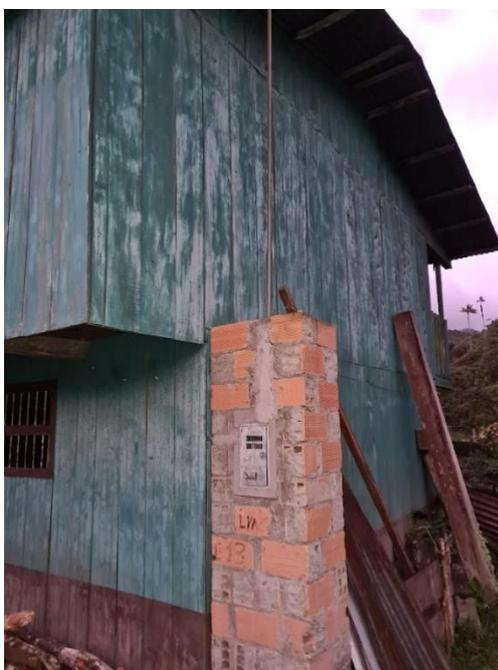
Estos muros tienen una menor longitud entablada, siendo esta 4.5 metros, para el presente análisis. Estimando el número de tablas ( $N_t$ ) por cada muro se puede calcular como:
