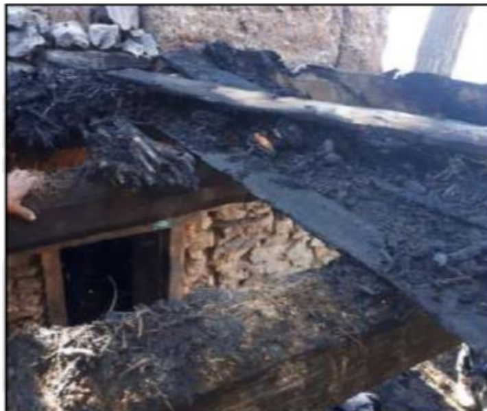
Figura 3.9. Incendio de una vivienda rustica Fuente: Instituto Nacional de Defensa Civil INDECI (2021)
