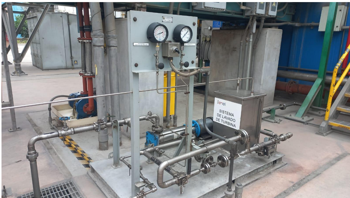
Figura 3.5: Sistema de lavado de la TG.
