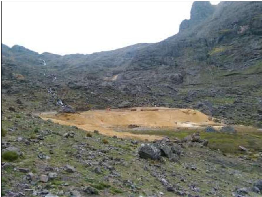
**Figura 3.6.** Deslizamiento del relave por erosión hídrica.
