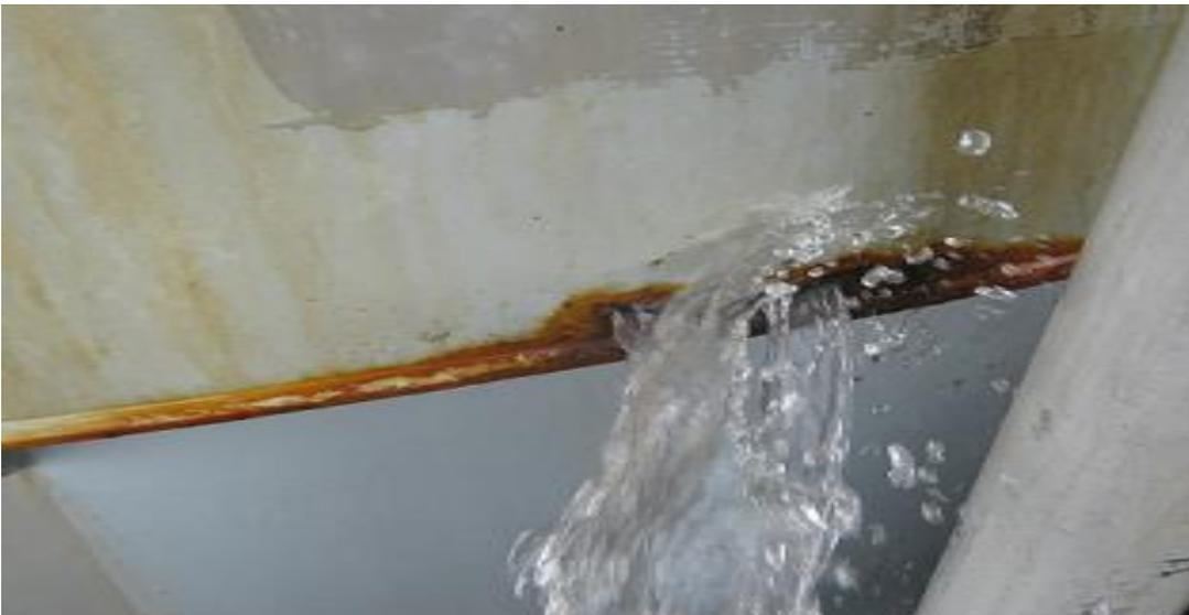
En la Figura 3 se muestra una fuga en un tanque que contiene solución cianurada. Aunque esta fuga fue considerada solo como una falla operativa y no se reportó como un evento peligroso, la recurrencia de estos incidentes ha llevado a frecuentes paradas no planificadas de la planta. Estas paradas causan pérdidas de producción y, en casos
