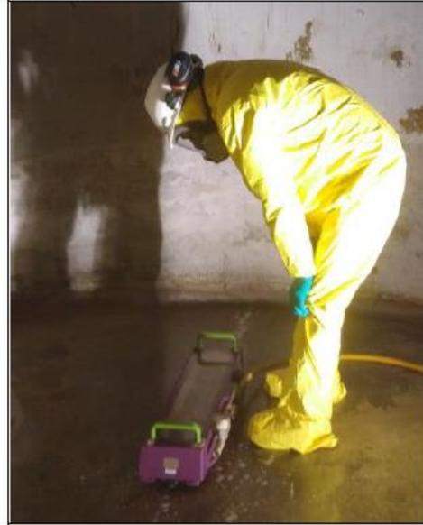
Se realizó la prueba de vacío al cordón #2 en el fondo del tanque
