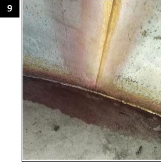
En la inspección visual(VT) no se evidencia daños en el shell parte interna del tanque como corrosión y pitting.
