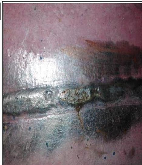
Se observa mal procedimiento de soldadura en el cordón central del fondo del tanque parte interna reportándose al personal de mantenimiento de MYSR para su inmediata reparación.
