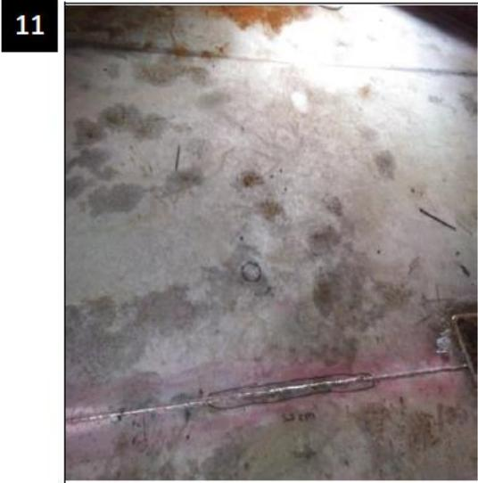
En la inspección visual(VT) del fondo del tanque se evidencia parche de 30x23cm, además en el fondo no se observa daños de corrosión y pitting en planchas.
