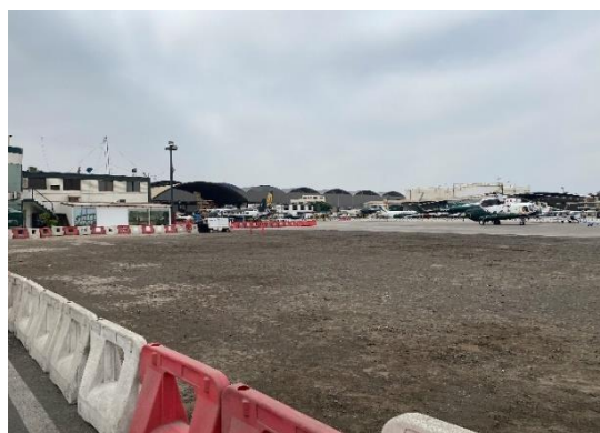
Zona de trabajo para la construcción de nuevo pavimento flexible
