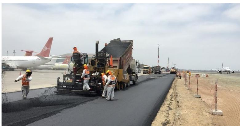
Colocación de mezcla asfáltica
