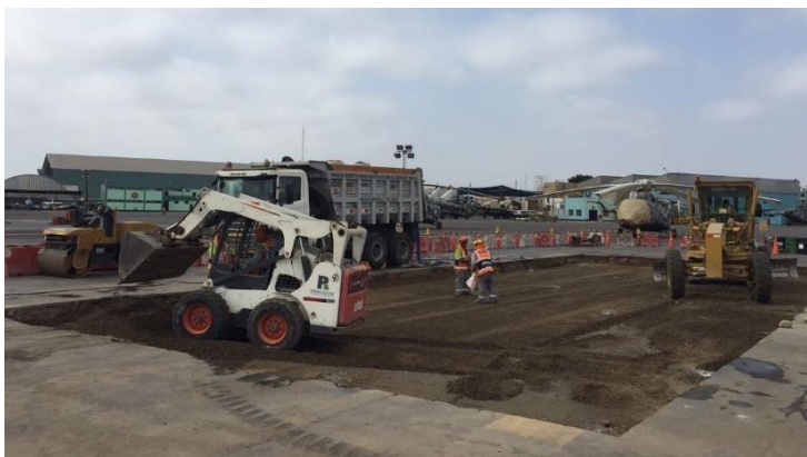
Conformación de base granular
