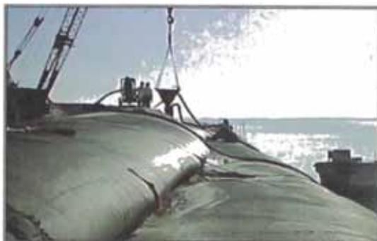
**Foto N° 3.2.- Instalación del geotubo, Fuente Manual de Ten Gate**
