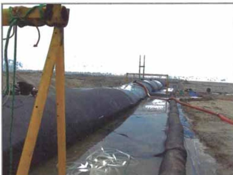
**Foto N° 3.7.- Llenado hidráulico del geotubo**
