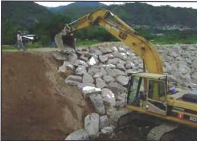
Foto N° 2.3.- Construcción de enrocado de protección
