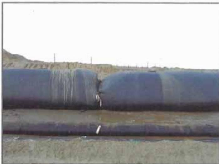
**Foto N° 3.9.- Geotubos colocados en forma lineal**
