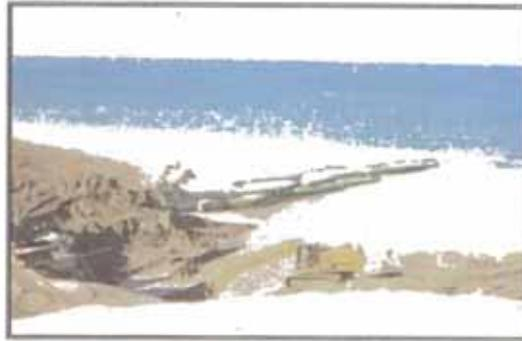
**Foto N° 3.4.- Geotubos colocados como espigones en México, Fuente Manual de Ten Gate**
