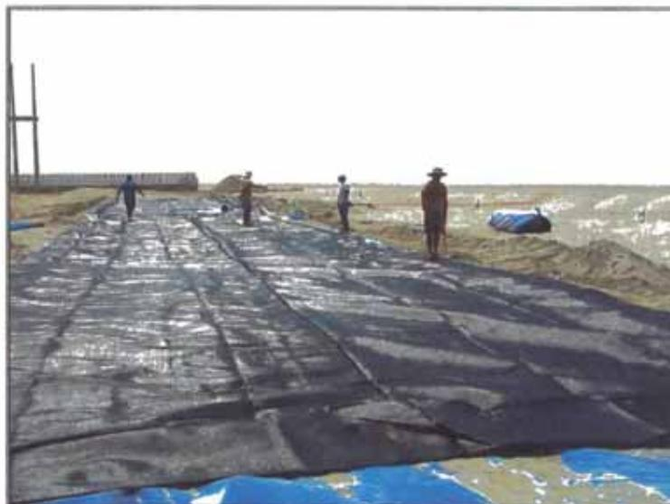
**Foto N° 3.6.- Tendido del rollo de manto antisocavación**
