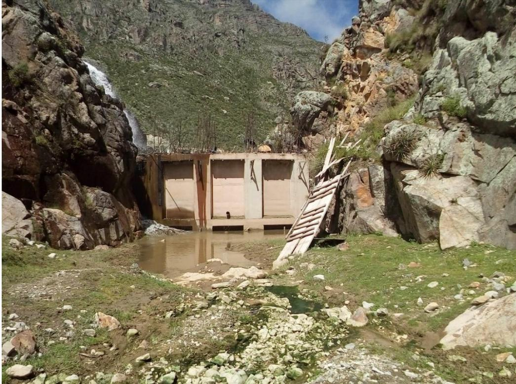
Figura N°4. Represa Potaga tipo Armco construido dos niveles hasta la paralización.
