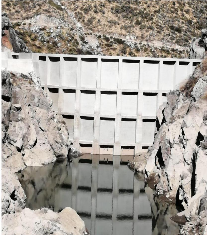
Figura N°20. Represa Potaga tipo Armco.
