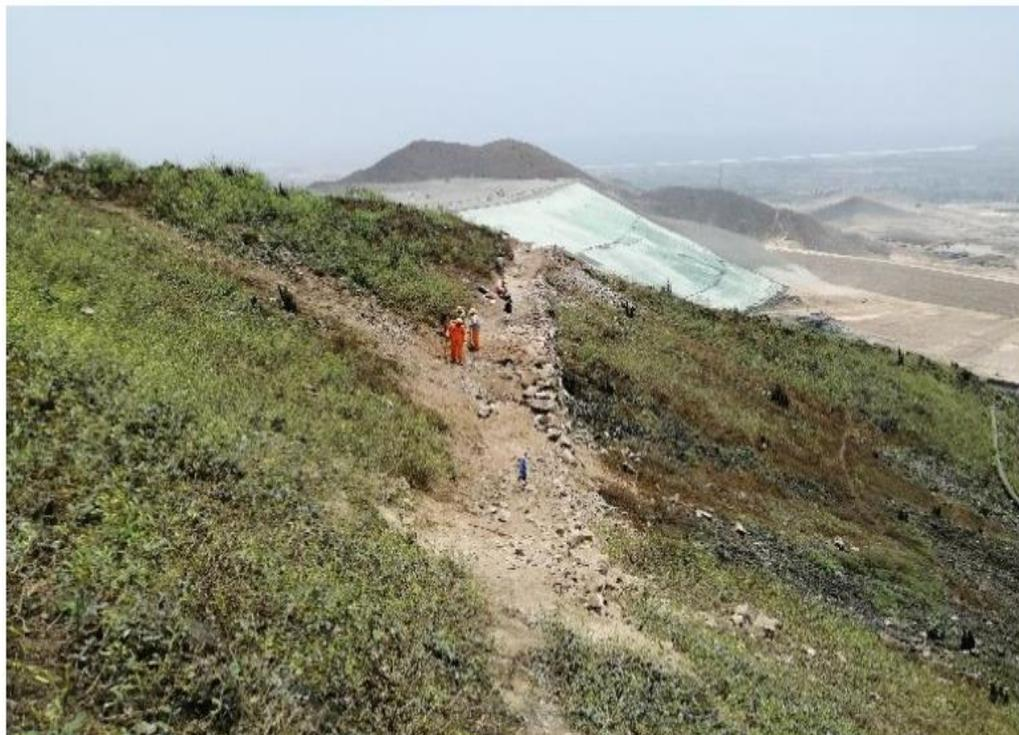
**Perfilado de terreno para apoyo de tubería HDPE**
