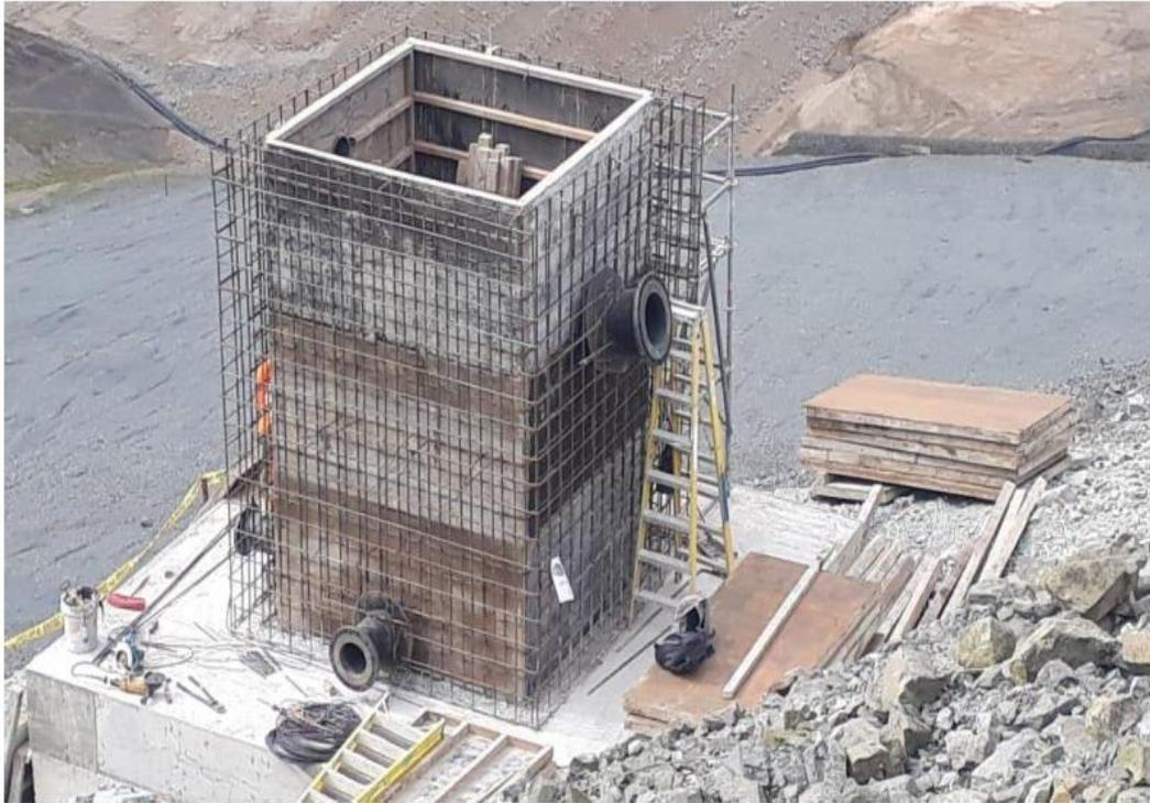
**Encofrado de muros de cajón y colocación de niples**
