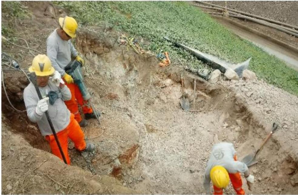
**Excavación de terreno rocoso para pedestales y cajones.**
