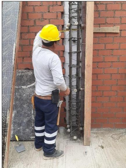
Figura 34: Colocación de dados de concreto prefabricado.
