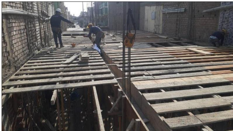
Figura 26: Encofrado de losa aligerada. Piso 1.
