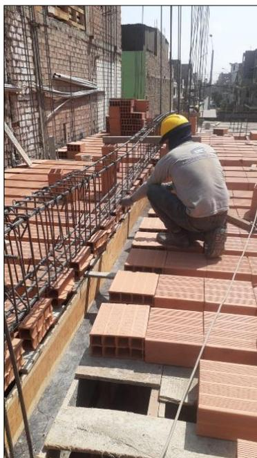
Figura 27: Armado de vigas del segundo nivel.
