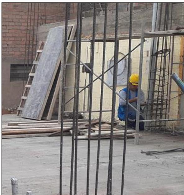
Figura 31: Acero de elementos verticales.
