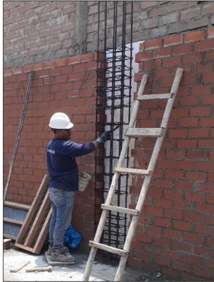
Figura 33: Limpieza de acero de columna.
