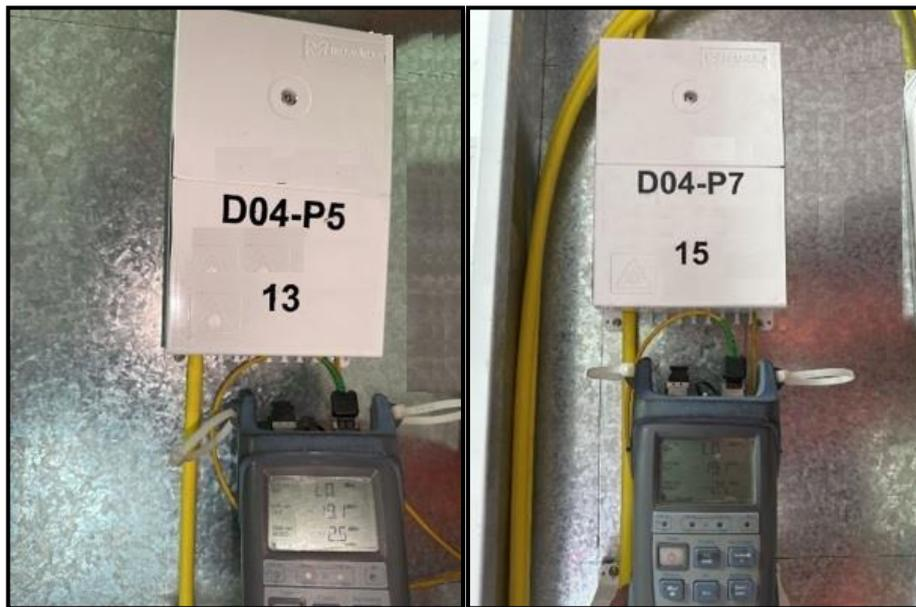
*Nota:* Figura muestra las mediciones de potencia óptica de los CTO 13 y 15 pertenecientes al *splitter* balanceado D04.
