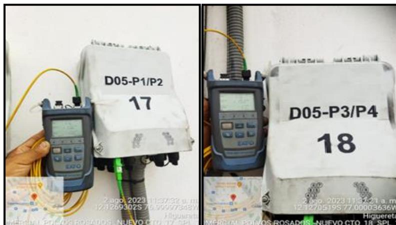
En la caja de paso ubicada en el tercer piso del centro comercial, se empalman 16 hilos del cable PKP con los 16 hilos del cable *riser*. Seguidamente, se continua con el despliegue del cable *riser* y con la instalación de los CTO internos en cascada desde el CTO 16 hasta el CTO 1. Las cajas internas están ubicadas en los montantes (cajas adosadas a la pared o dentro de la pared, donde se almacenan equipos de telecomunicaciones).
