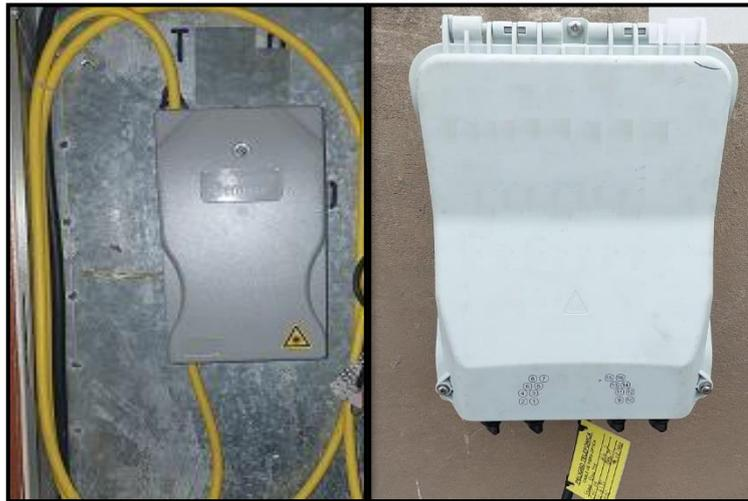
*Nota:* se muestra CTO interno y cable riser (izquierda) y CTO externo (derecha), acá se alojan los *splitter* de segundo nivel.
