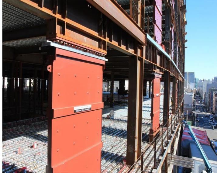
Figura N° 19 Muro de fluido viscoso instalado en una estructura de acero (Fuente: DIS)
