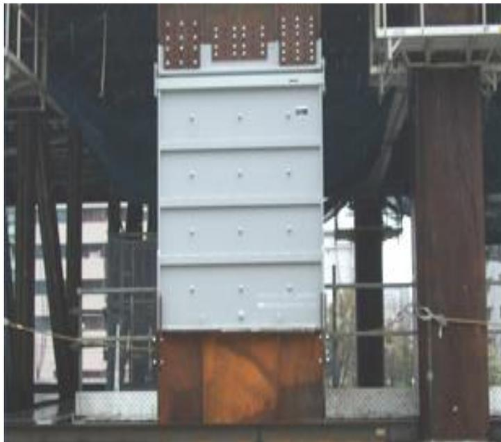
Figura N°23 Muro de fluido viscoso instalado en obra. (Fuente OILES)
