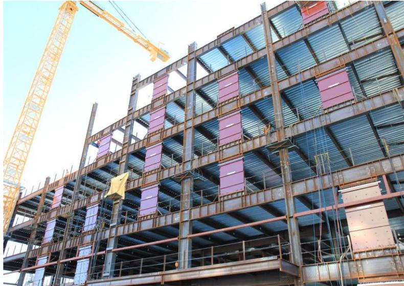
Figura N° 32 Ubicación perimetral de muros viscosos como criterio estructural. (Fuente: DIS)
