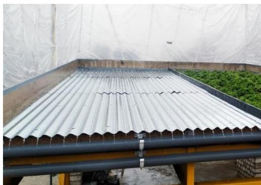
Figura 36: Techo de Calamina galvanizada.
