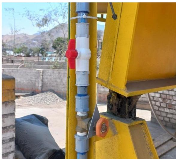
Figura 44: Válvula de compuerta
