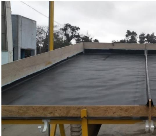
Figura 33: Capa impermeable anti-raíces, Geomembrana HDPE de 1 mm.
