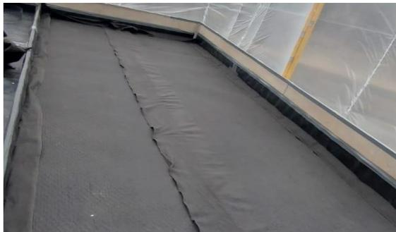
Figura 31: Capa de drenaje y filtro, Geodren Planar
