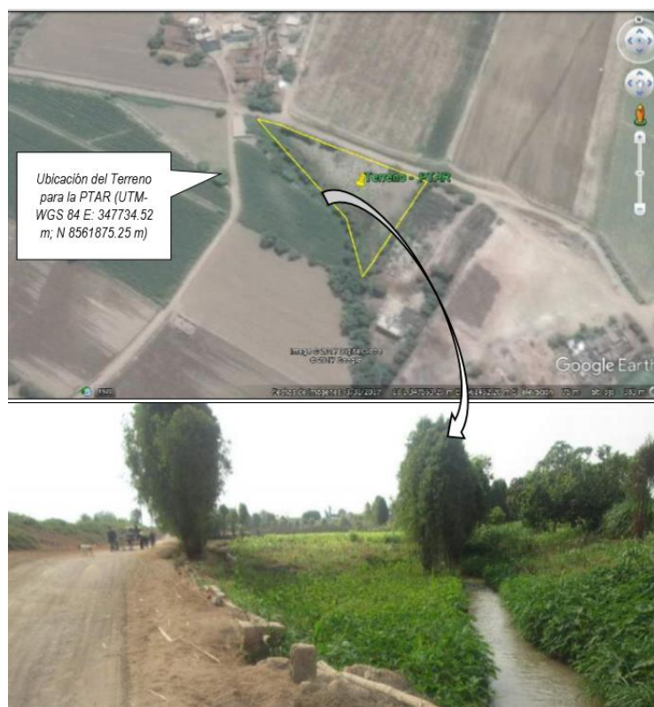
Figura 14 Ubicación de la Planta de Tratamiento de Aguas Residuales (PTAR)
