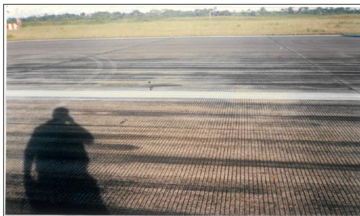
Figura N° 16. Ranurado de la superficie de rodadura de la pista del Aeropuerto de Iquitos
