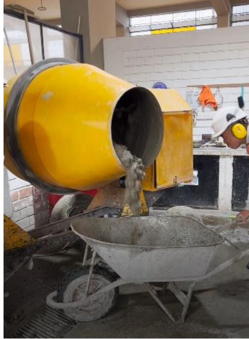
Figura N°18: Preparación de la mezcla en el trompo
