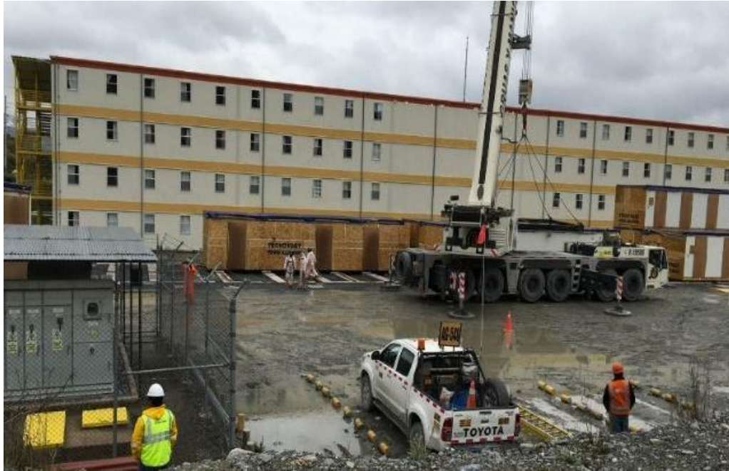
Figura N°4: Montaje de un campamento minero modular
