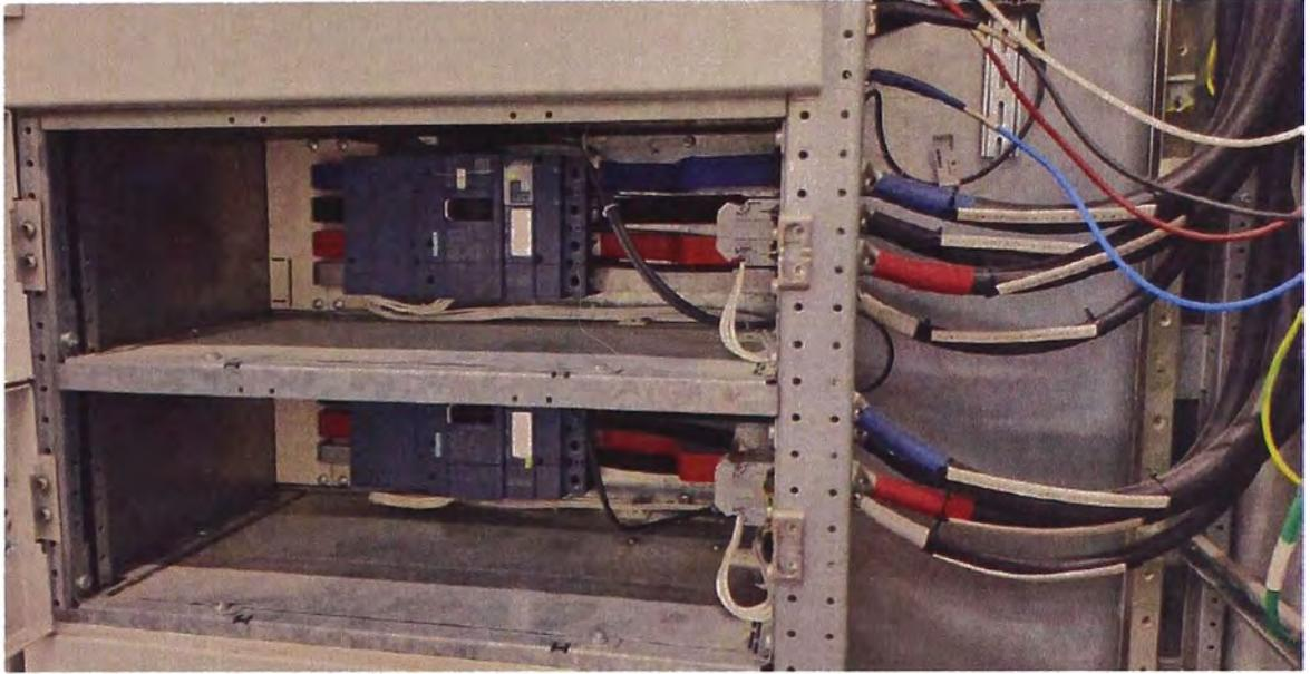
**Foto 1:** Interruptores de salida Q43 hacia Tablero AMA y Q44 hacia Tablero AMA Ext.
