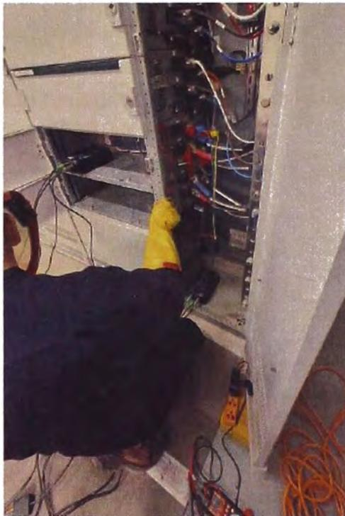
**Foto 2:** instalación de equipos analizadores UNIPower Unilyzer 900 en el Tablero Principal TGBT-E de la subestación 1220
