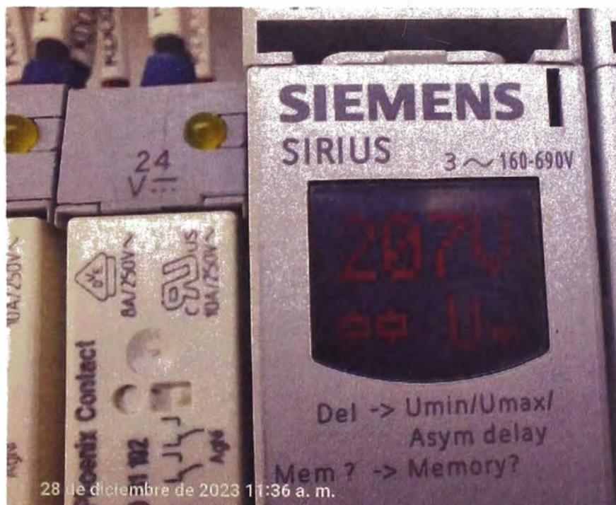
Foto 6: Ajuste de corrección de forma manual para mínima tensión en el RELE 3UG4618
