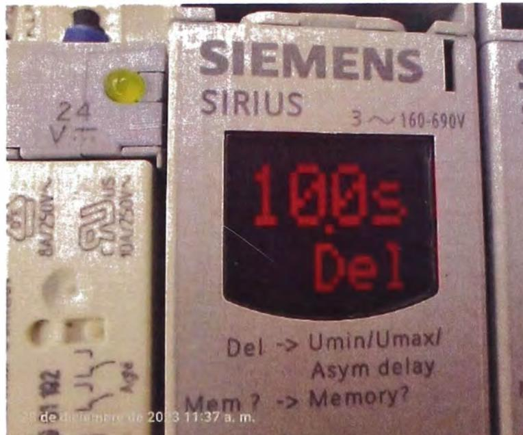
Foto 7: Ajuste de corrección de forma manual para el Retardo de disparo (Del) en el RELE 3UG4618
