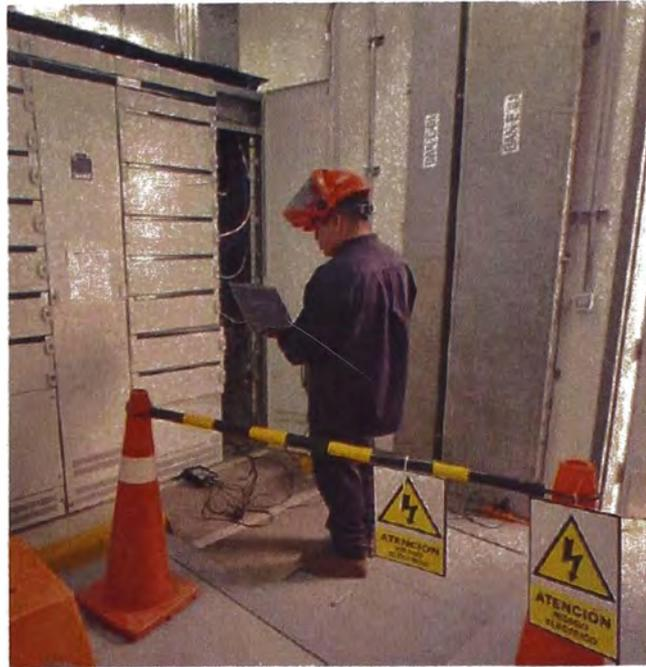
Foto 3: Configuración de los equipos analizadores UNIPOWER Unilyzer 900 en el Tablero Principal TGBT-E de la subestación 1220
