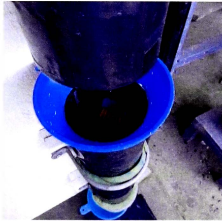
Fotografía N° 9 Separación de 10 cm entre módulos
