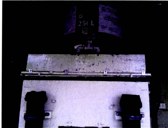
Fotografía N° 2 Tanque de Almacenamiento del efluente del reactor UASB
