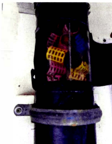
Fotografía N° 14 Ventana de inspección del reactor DHS a escala piloto. Se visualiza las esponjas en la semana 38 de la investigación
