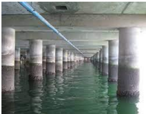
Figura 2.2 Muelle con pilotes
