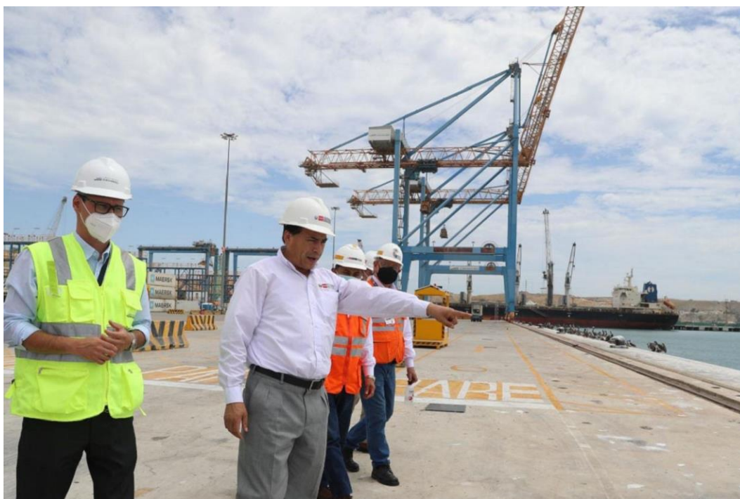
Supervisión en los trabajos de muelles marítimos de Paqueta
