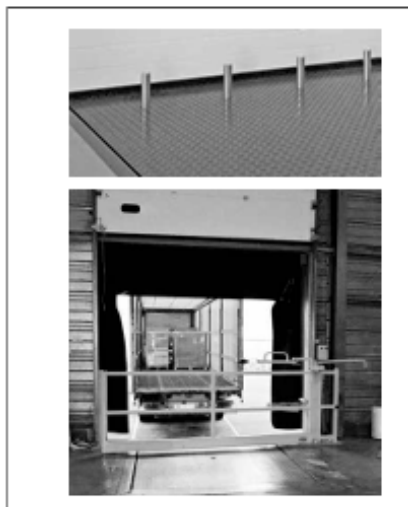
Figura 33. Rampa con bulones extraídos y barrera metálica.
