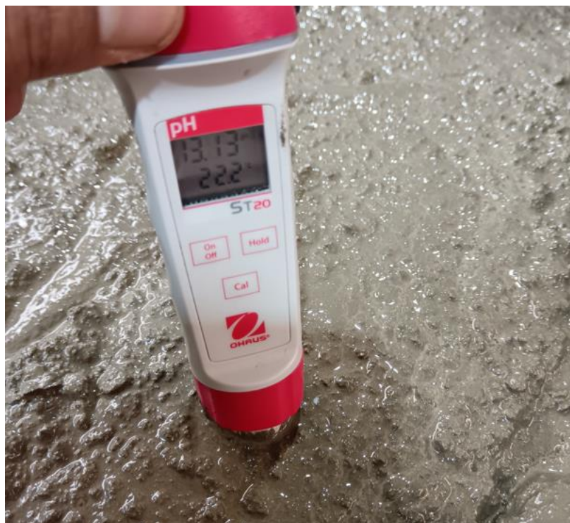
Figura N° 9: Medida de la temperatura y pH del grout fresco (Nota: Elaboración propia)
