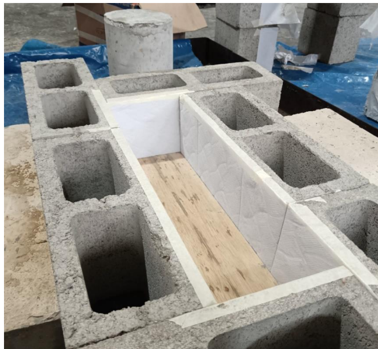
Imagen 17. Molde absorbente de testigo de grout de tipo viga (Nota: Fotografía propia)
