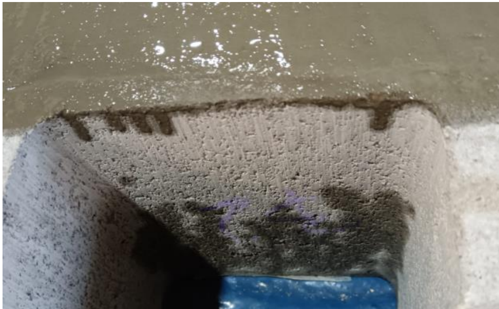
Figura N° 54: Bloque de concreto húmedo en contacto con la mezcla de grout (Nota: Fotografía propia)
