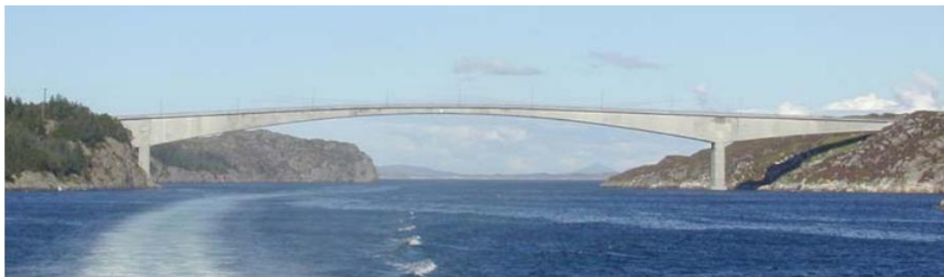
Figura 12: Puente segmental de concreto construido en voladizos sucesivos
