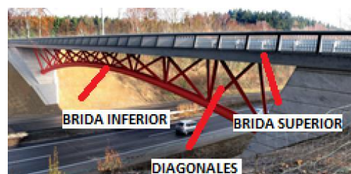
(d) Paso elevado Lindach-Vorchdorf (Austria)
