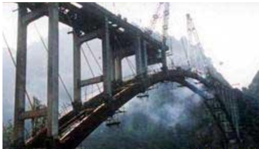
Figura 27: Vista del proceso constructivo, nótese el empleo de una grúa por frente de construcción
