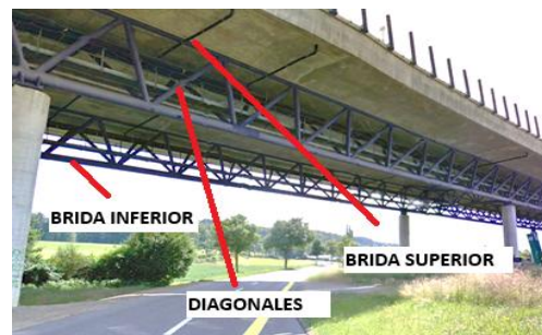
(b) Viaducto Lully (Suiza)
