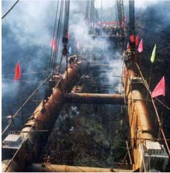
Figura 29: Tubos metálicos montados en el arco principal del puente Tianzhishan
