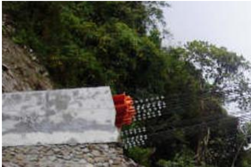
Figura 48: Anclaje en roca empleado en Puente Yanango
