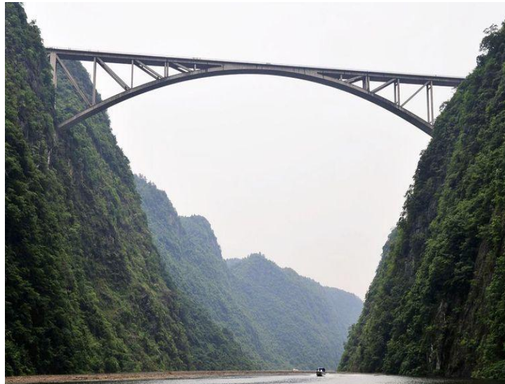
Figura 19: Fotografía de la elevación del puente Jiangjie, China
