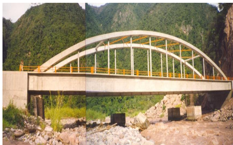
Figura 9: Puente Río Colorado (Carretera La Merced – Satipo)
