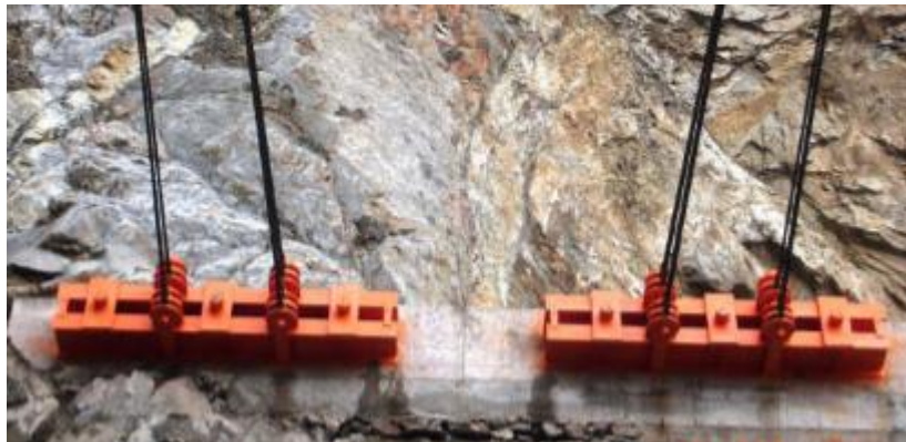
Figura 49: Vista frontal de mecanismo de anclaje en roca
