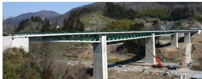
(a) Puente Shitsumi-Ohashi
