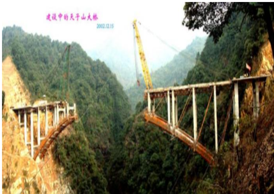
Figura 31: Etapas de voladizos del puente Tianzhishan, China
