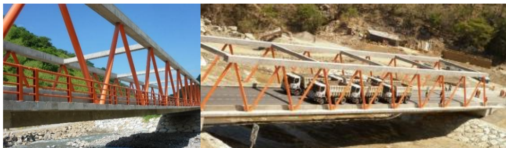
Figura 7: Puente el Silencio (Eje multimodal Amazonas Norte, Tramo 4 Olmos – Corral Quemado, Lambayeque)
