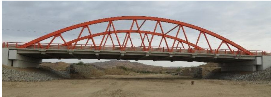
Figura 8: Puente el Abejal (Tramo Piura – Guayaquil, Tumbes)
