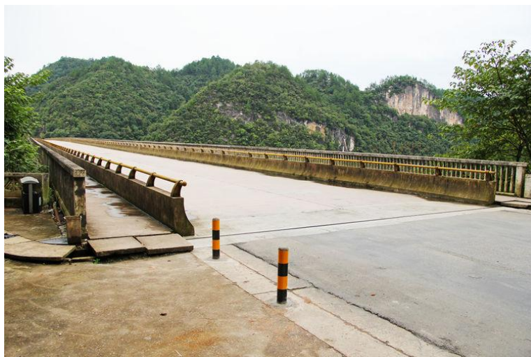
Figura 24: Vista de accesos al puente Jiangjiede, China
