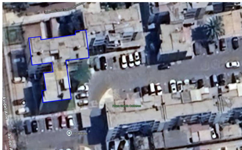
FIGURA N° 1.1: Imagen de planta irregular de estructura en el condominio de la Plaza García Calderón.
