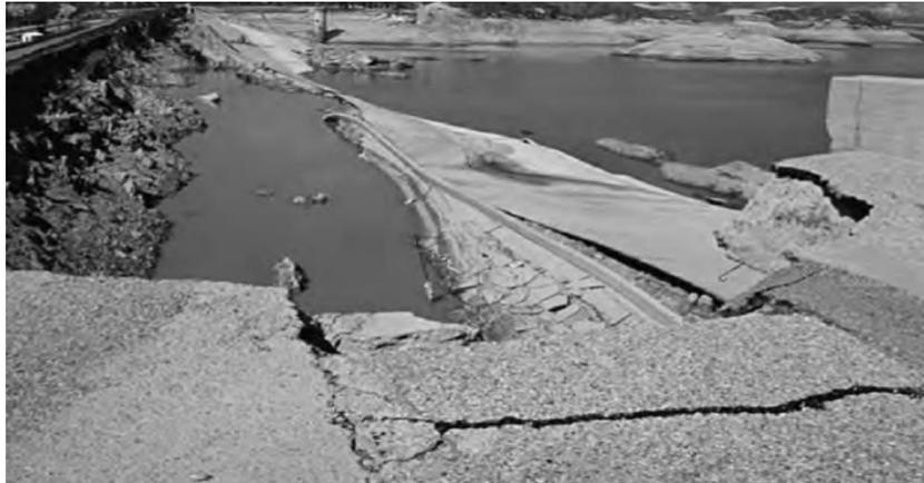
Figura 2.8: Deslizamiento en el talud aguas arriba en la presa de San Fernando después del sismo de San Fernando 1971
