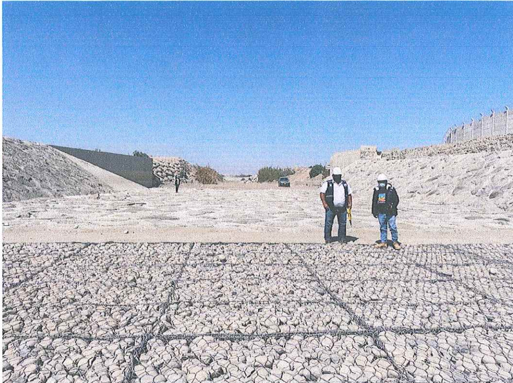
Comité de Recepción verificando fijador de rasante y gabión tipo colchon
