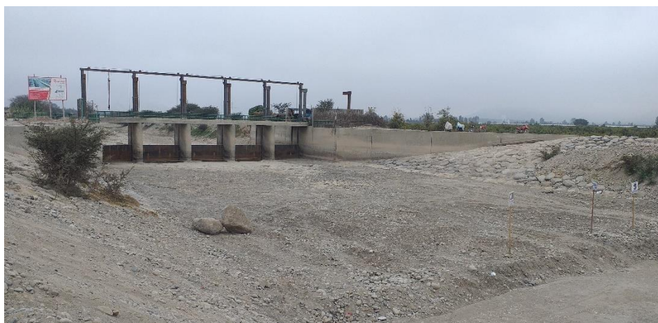
Figura N° 5: Vista del Sector I, Tramo I. Se observa cartel de obra.
