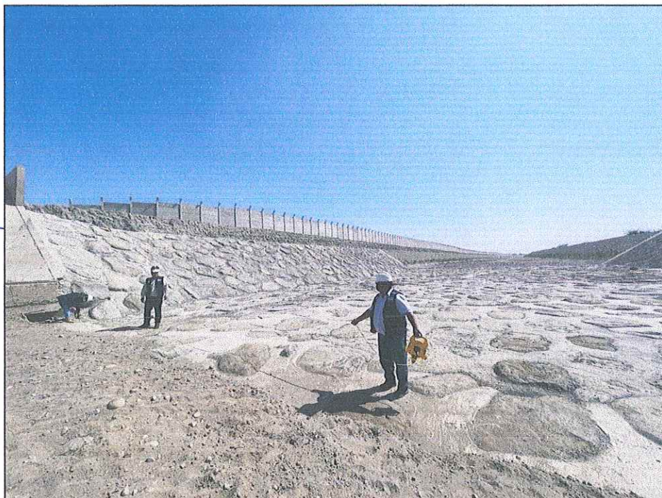
El Comité de Recepción verificando enrocado emboquillado Vertedero Saraja
