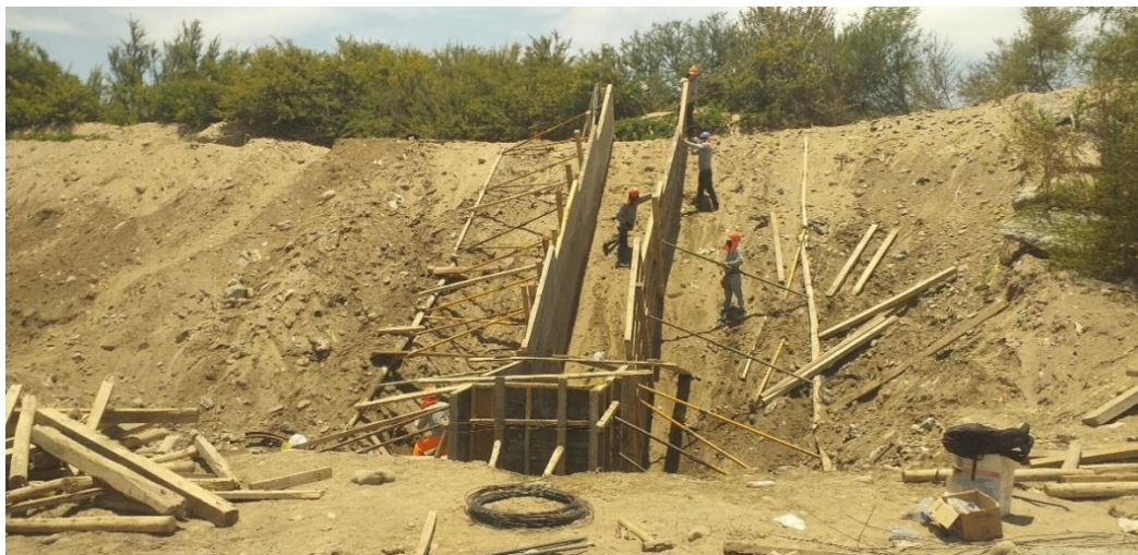
Figura N° 9: Imagen para panel fotográfico: Encofrado para vaciado de estabilizadores de concreto armado
