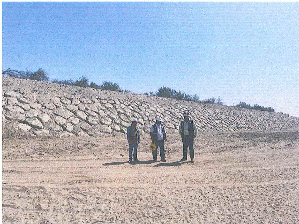
Comité de Recepción verificando enrocado
