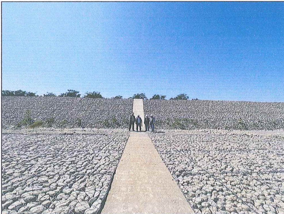
Comité de Recepción verificando fijador de rasante
