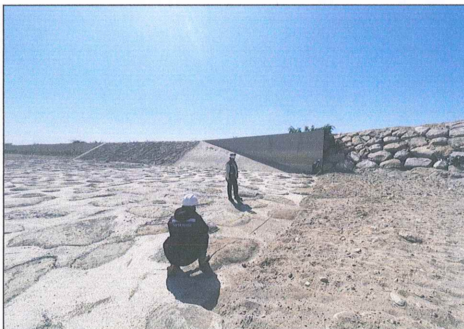
El Comité de Recepción verificando estructuras hidráulicas – Vertedero Saraja
