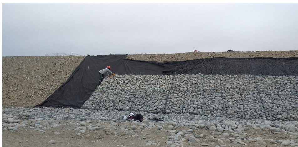
Figura N° 7: Ejecución de gaviones
