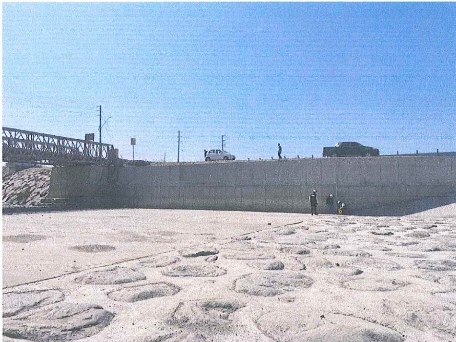
Comité de Recepción verificando estructuras hidráulicas Puente San Juan
