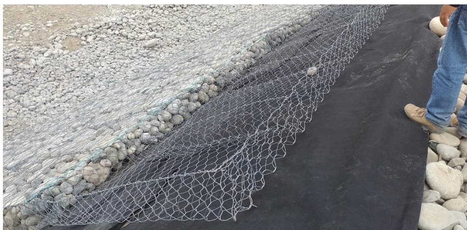
Figura N° 6: Ejecución de gaviones
