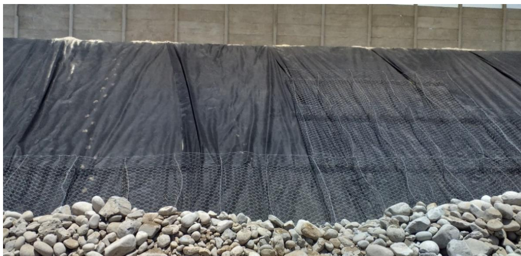
Figura N° 10: Imagen para panel fotográfico: Colocación de mallas para gaviones
