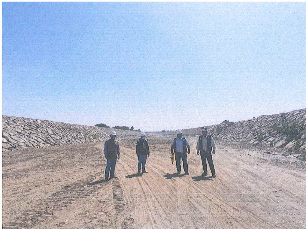
Comité de Recepción verificando enrocado y sección hidráulica del río
