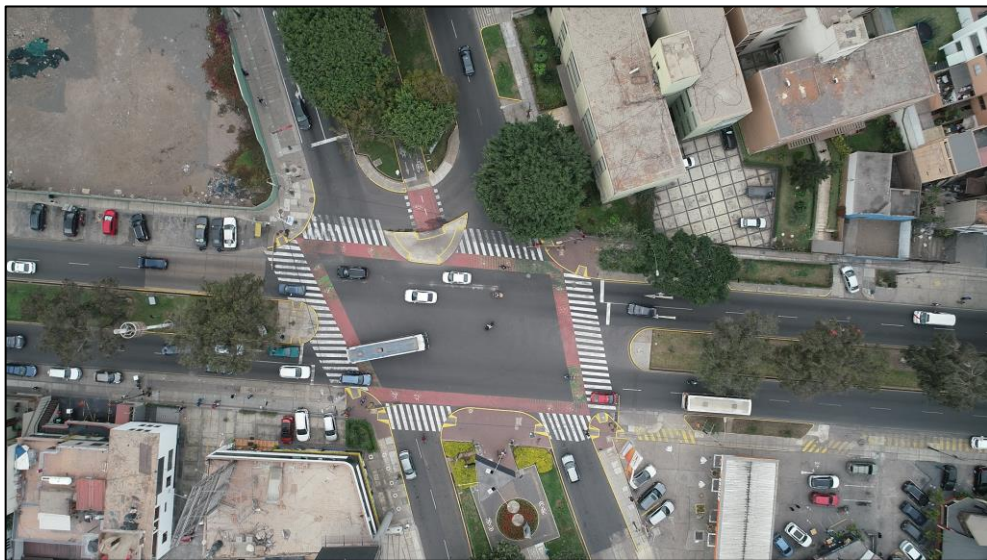
Figura N° 5.2 Vista aérea de la intersección Av. Salaverry - Av. Pérez Aranibar.
