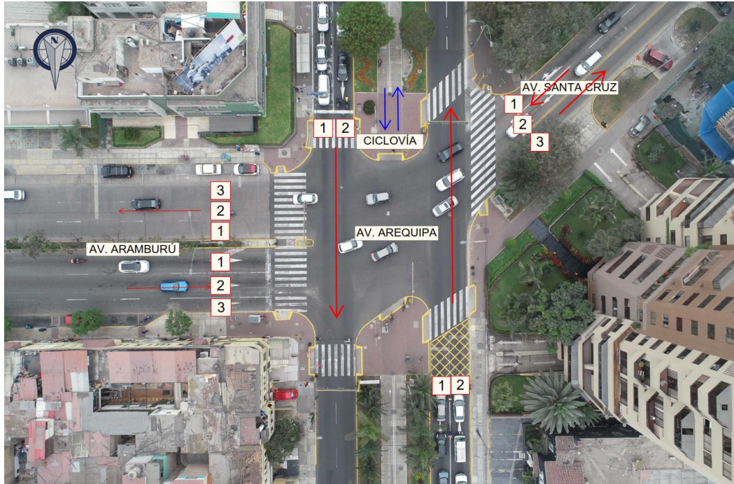
Figura N° 4.13 Vista aérea de la intersección entre Av. Arequipa, Av. Aramburú y Av. Santa Cruz.
